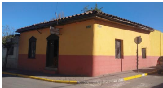
Tratamiento de esquinas en sector Chacabuco
