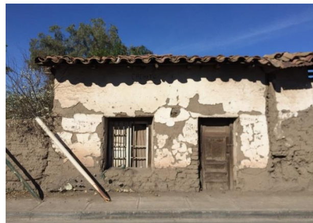
Edificación en mal estado hacia calle Comercio esquina Eduardo Weggner Fuente: CMN año 2018
