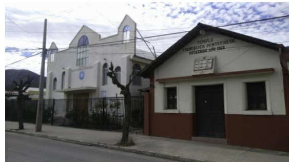
Construcciones aisladas (discordantes) hacia calle Sarmiento entre O'Higgins y Vicuña Fuente: Surplan 2017
