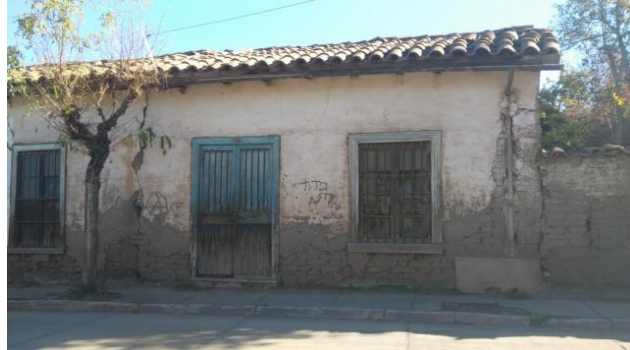
Edificación en mal estado hacia calle Chacabuco, entre Bernardo O'Higgins y Buin Fuente: Surplan año 2017
