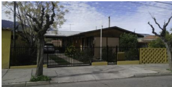
Construcciones aisladas (discordantes) hacia calle Sarmiento esquina O'Higgins Fuente: Surplan 2017
