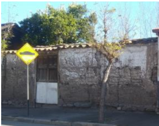
Edificación en mal estado hacia calle Chacabuco Fuente: Surplan año 2017
