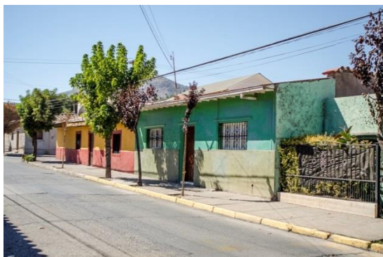
Construcciones de calle Sarmiento entre Aspee y O'Higgins Fuente: CMN 2017
