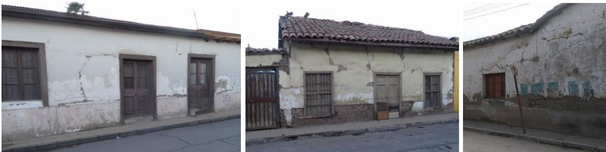
Edificaciones en mal estado hacia calle Comercio
