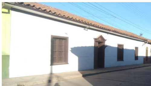
Construcción continua de un piso en calle Chacabuco
