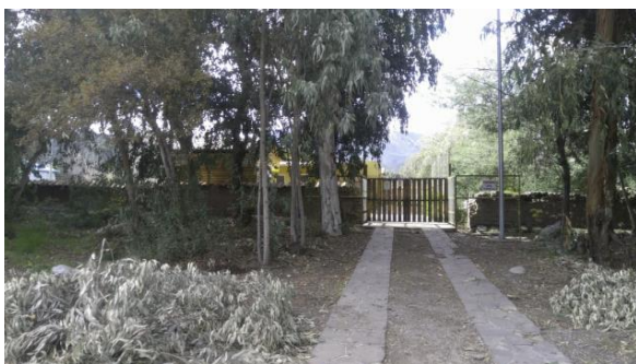
Construcción con cierro de piedra y argamasa de tierra hacia avenida Alejandrina Carvajal Fuente: Surplan 2017
