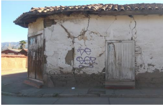
Edificación en mal estado hacia calle Chacabuco, esquina Bernardo O'Higgins. Fuente: Surplan año 2017
