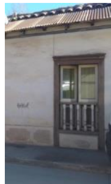
Balaustres de ventanas hacia calle Chacabuco Fuente: Surplan 2017
