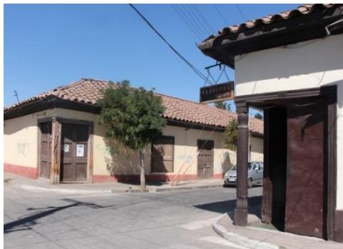
Con pilar de esquina - Calle Comercio Fuente: CMN 2017
