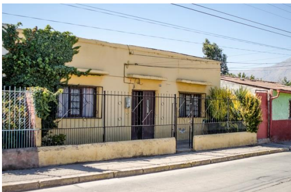
Construcciones hacia calle Sarmiento con antejardín Fuente: CMN 2017
