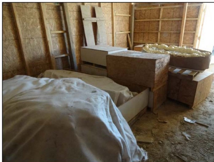
Fig 16. Vista general del material almacenado en obra.
