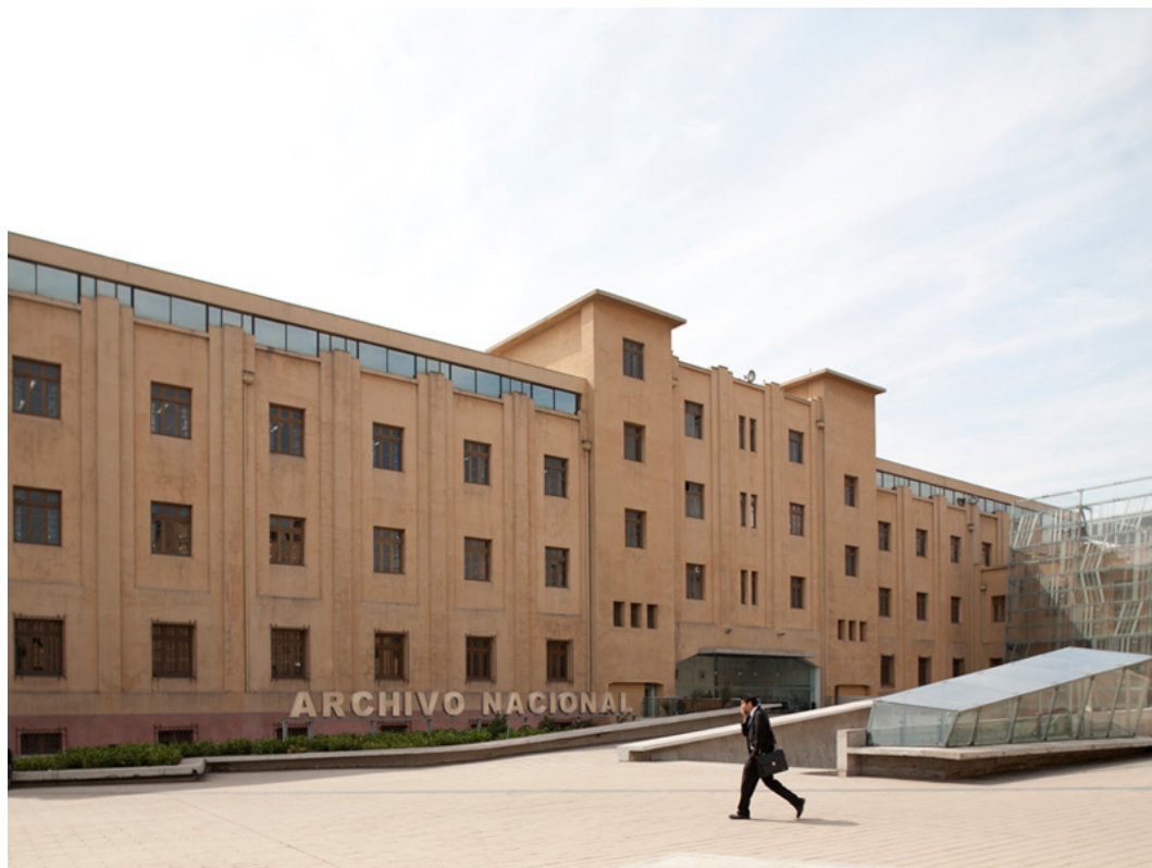
Rampa de acceso al Archivo Nacional de la Administración. Fuente: Servicio Nacional del Patrimonio
