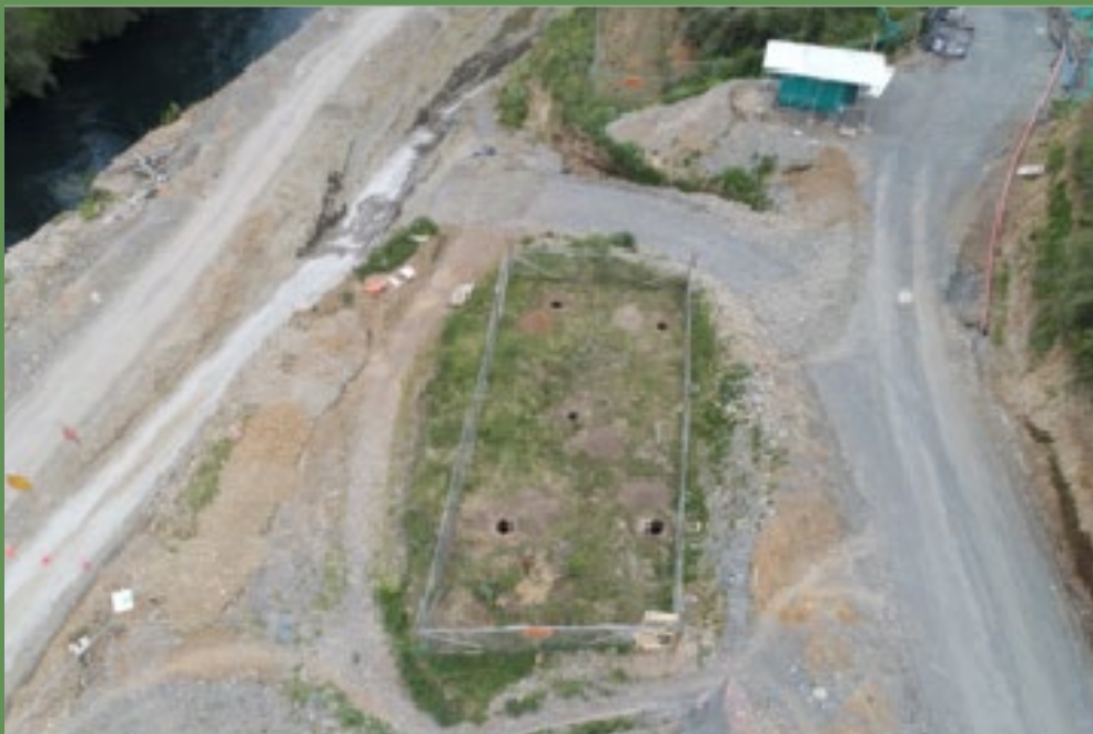
Figura No. 20. Sitio SA-13. Vista aérea donde se observan los pozos excavados durante la caracterización arqueológica de noviembre 2021.
