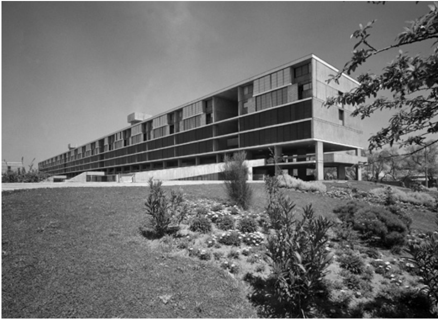
Fig. 2 Vista general Unidad Vecinal Portales. Bloque habitacional y espacios comunes.
