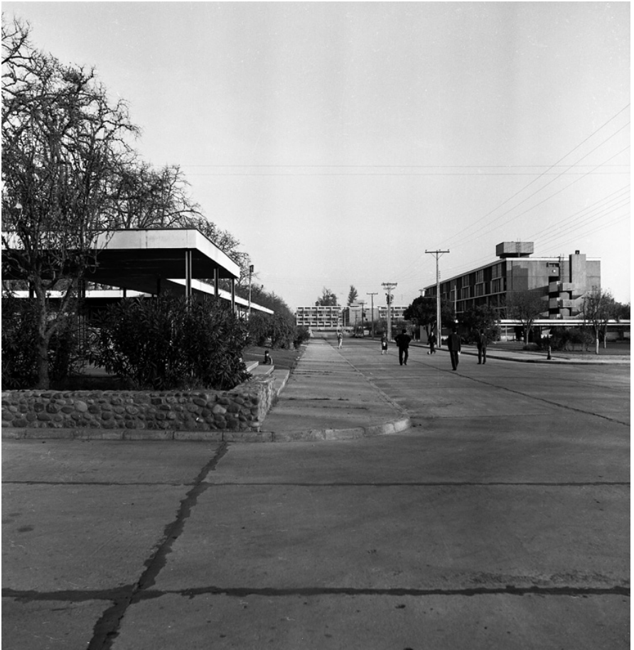
Fig. 3 Vista general del conjunto Unidad Vecinal Portales.
