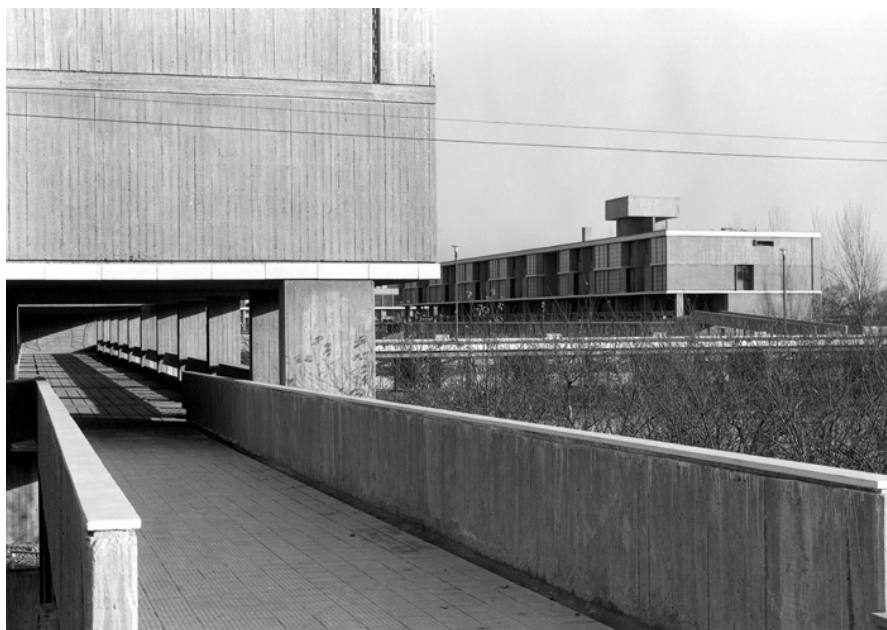
Fig. 12 Vista a espacios de circulación cubiertos y su relación visual con el parque al interior del conjunto.
