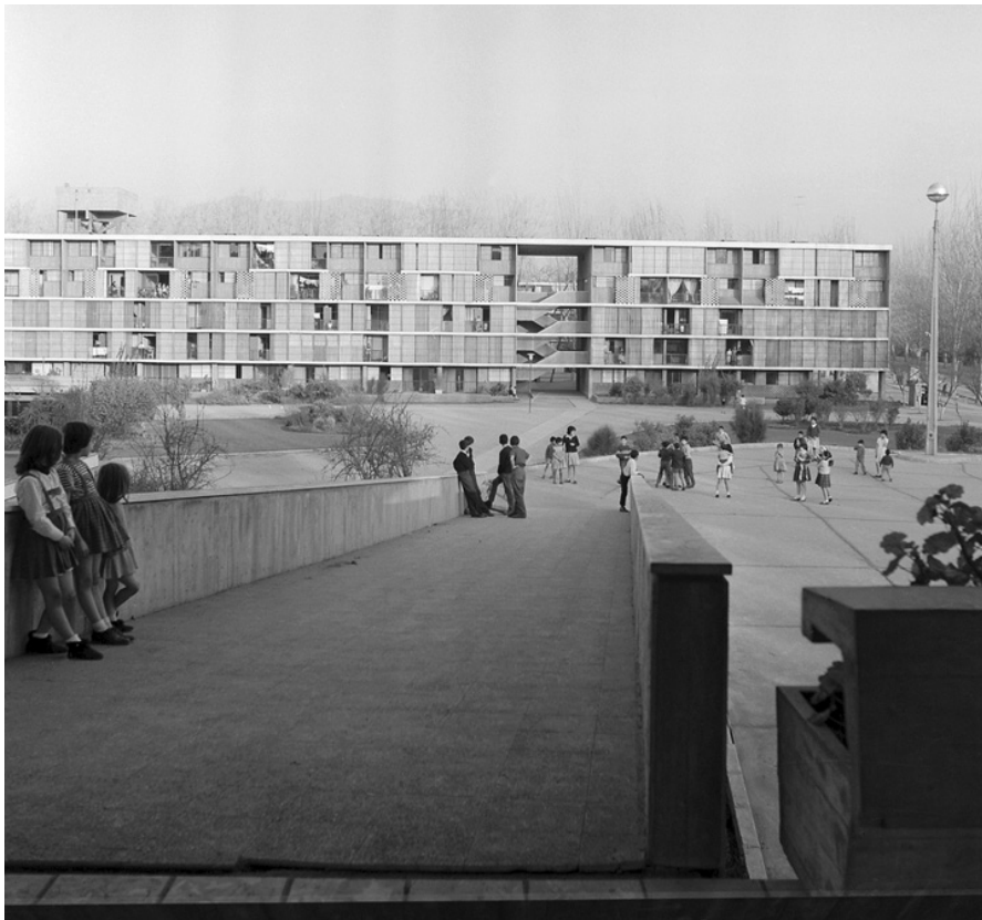
Fig. 6 Vista de áreas comunes desde espacios de circulación.
