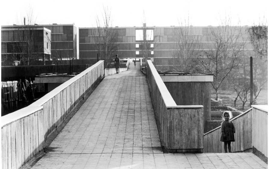
Fig.9 Vista de circulaciones entre bloques y pasarelas peatonales.
