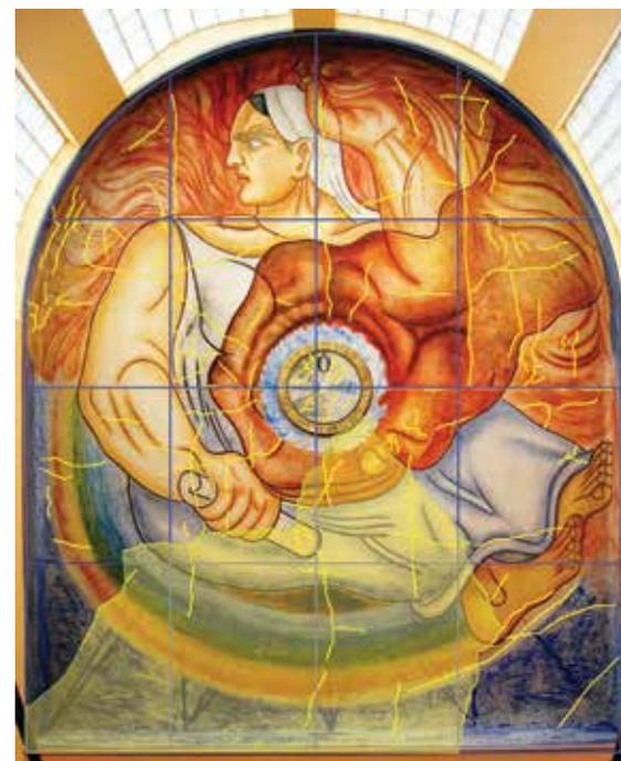
Figura 33. Sobre una fotografía digital del mural ubicado en el techo que cubre la escalera principal se superpusieron las fisuras observadas antes del sismo, la retícula que delimita los bloques del plafón, así como la superficie que abarcaba el bloque desprendido.
