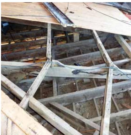
Figura 39. Retiro en proceso de la techumbre original para poder tener acceso a la parte superior del mural del maestro Guerrero.
