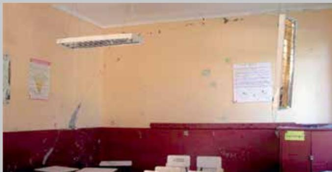
Figura 12. Agrietamientos típicos en muros transversales.
