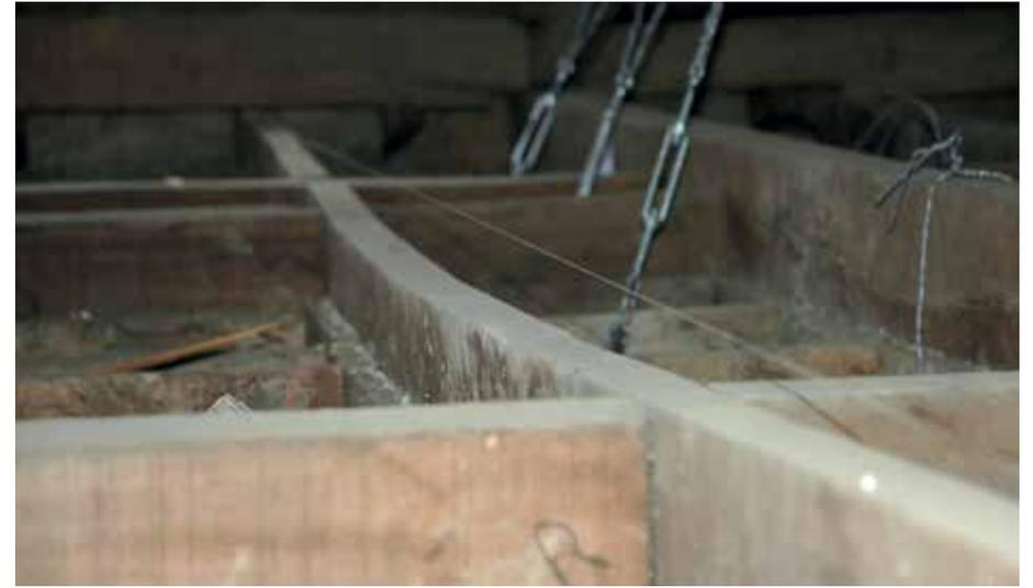
Evidencia del grado de flexión de una viga maestra que sostiene la losa.
