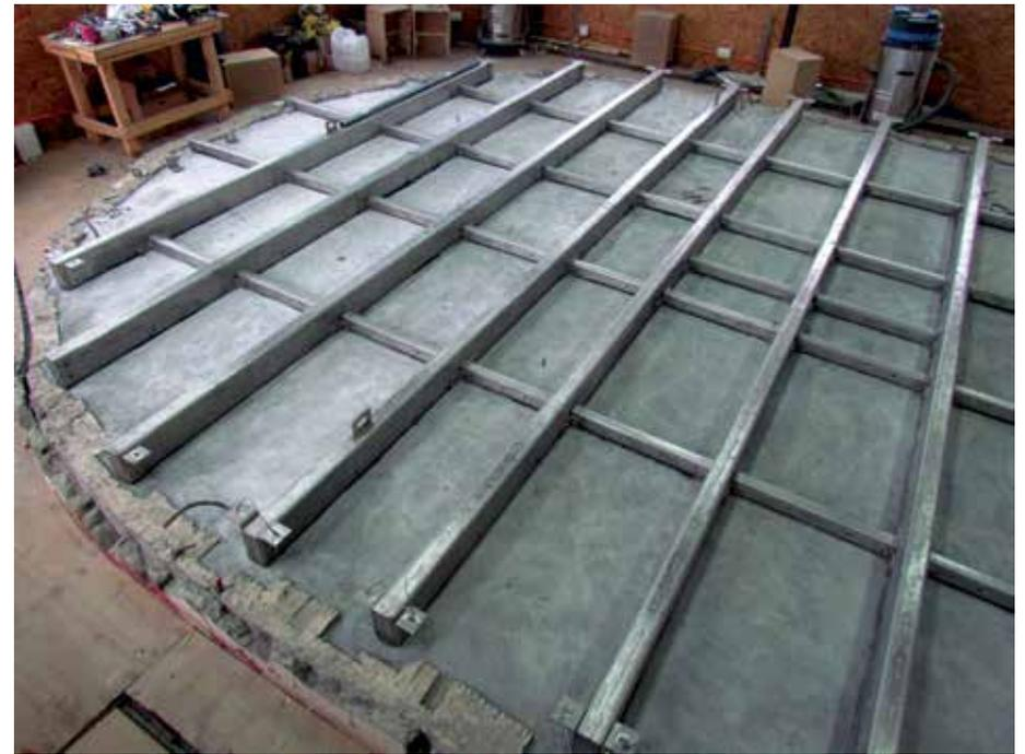
Figura 52. Nuevo bastidor apoyado sobre el plafón ya rehabilitado.
