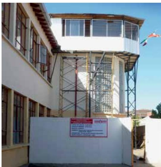
Figura 38. Estructura temporal para cubrir la zona del cubo de escalera y tener acceso a la parte superior del mural del maestro Xavier Guerrero.
