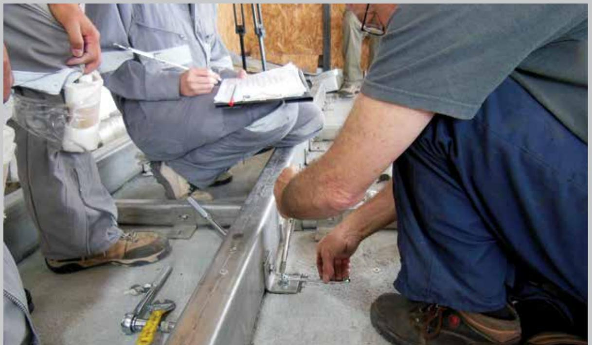
Figura 53. Fijación del plafón al nuevo bastidor mediante tornillos anclados con taquetes.
