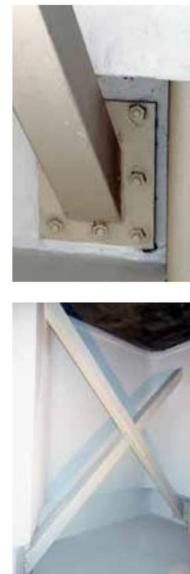
Figura 8. Vista de un juego típico de elementos de refuerzo y detalle de la conexión entre este y las columnas originales del edificio.
