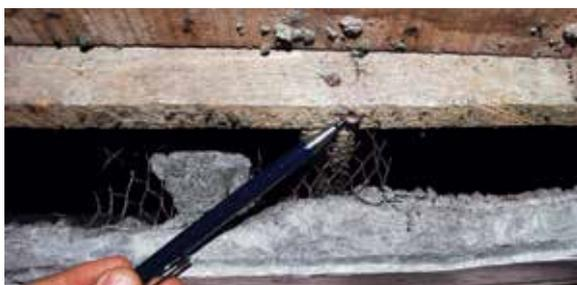
Figura 25. Detalle de la separación entre el plafón, formado por la gruesa capa de mortero, y el bastidor; obsérvese el desgarramiento del mortero causado por la separación de la malla metálica.
