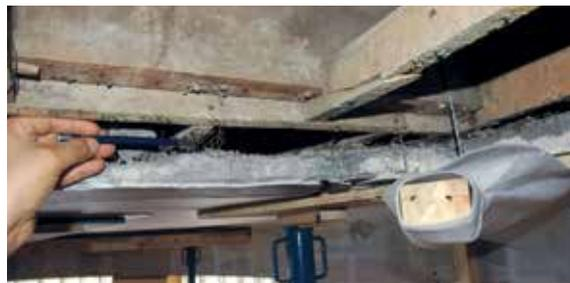
Figura 26. Detalle de la separación entre el plafón, formado por la gruesa capa de mortero, y el bastidor; obsérvese que el peso completo del plafón estaba soportado exclusivamente por la unión entre grapas y la malla metálica. A la derecha puede apreciarse la presencia de una grieta en el plafón cuya tonalidad oscura indica que esta existía antes del sismo de 2010.
