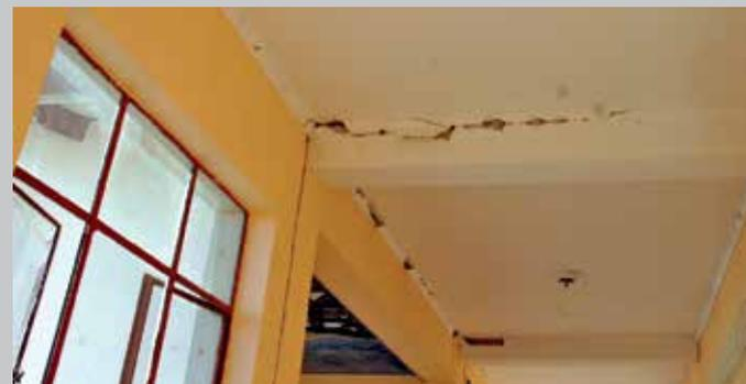
Figura 15. Daños en el plafón, en la zona donde este se une con las vigas de concreto.
