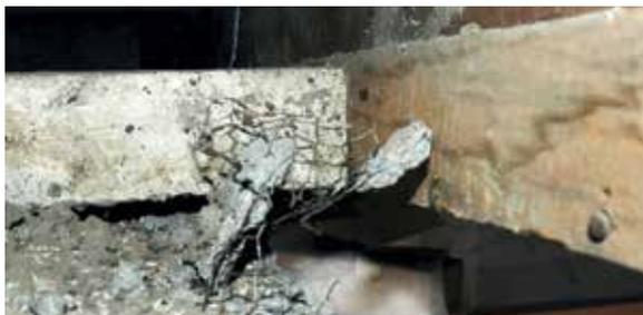
Figura 24. Detalle de la separación entre el plafón, formado por la gruesa capa de mortero, y el bastidor. Asimismo se muestra la fractura en uno de los elementos de madera del bastidor.
