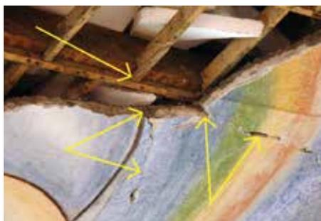
Figura 32. Los agrietamientos en el plafón atraviesan su espesor completo.
