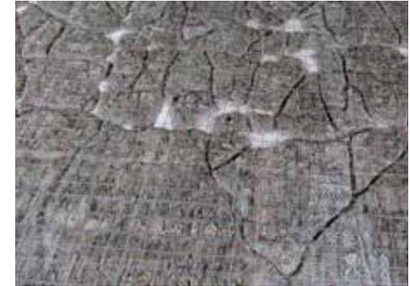
Figura 48. Vista general y detalle de la malla de acero inoxidable sobre el plafón antes de vaciar la capa de mortero de alto desempeño; obsérvense los surcos entre los distintos fragmentos recuperados del mural, estos quedaron rellenos de mortero al momento de realizar el vaciado.
