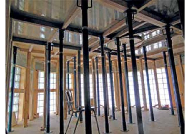
Figura 36. Puntales de madera y alzaprimas para transmitir el peso del mural hacia la plataforma inferior.
