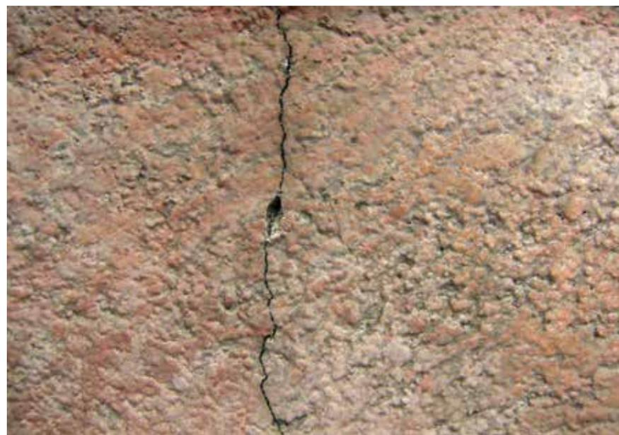
Detalle: ejemplo de grieta no original que resalta visualmente atravesando un elemento iconográfico especialmente importante. Esta se formó a consecuencia de movimientos estructurales posteriormente a la realización de la obra. También se aprecia un pequeño desprendimiento, probablemente causado por el terremoto de 2010.
