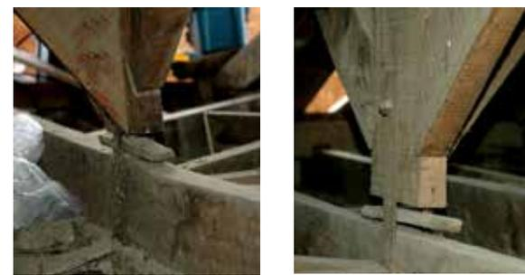
Figura 29. Desajustes en conexiones de la estructura de madera que soporta al mural.
