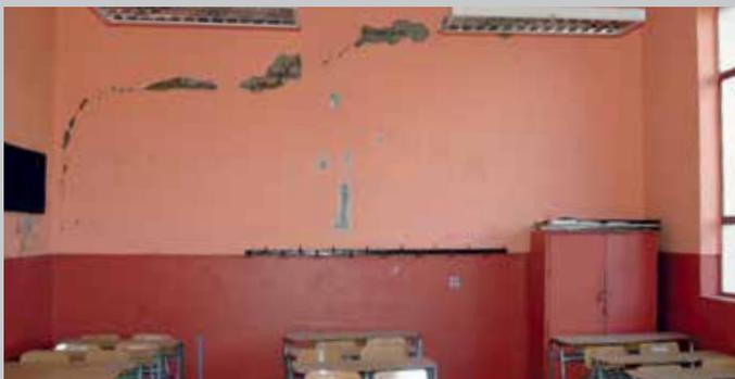
Figura 13. Agrietamientos en muros transversales; este muro delimita el extremo sur de la biblioteca, atrás de él se encuentra parte del mural *Muerte al invasor*.
