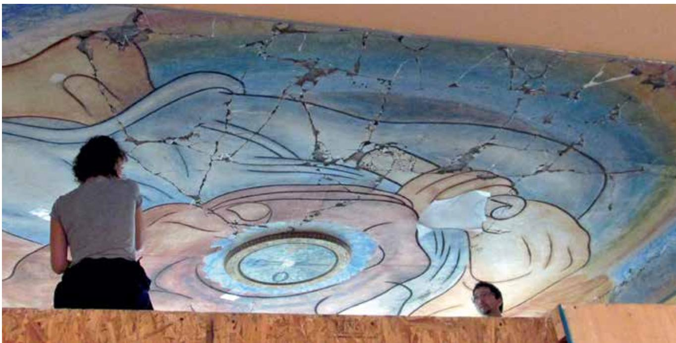
Figura 61. Vista del mural al concluir la instalación de las anclas complementarias; con ello también concluye la consolidación y el refuerzo del plafón y se inicia la etapa de restauración de la pintura.
