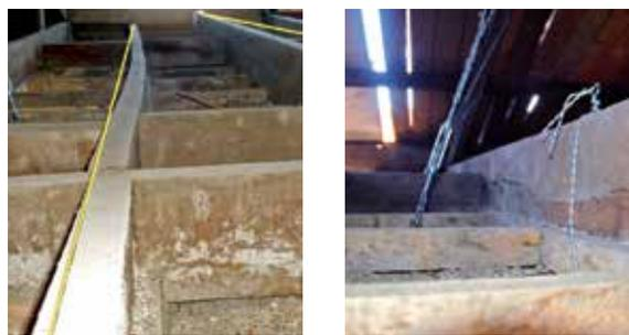
Figura 27. Deflexiones excesivas tanto en el plano vertical como en el horizontal de las vigas de madera que dan soporte al mural. Asimismo se aprecia separación entre el plafón y el bastidor de madera. En la imagen del lado derecho, además, se aprecia una grieta longitudinal.
