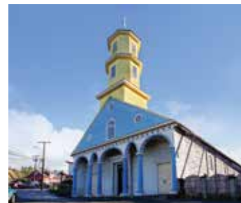
Torre Fachada, Iglesia Chonchi © Cristian Larrere W.
