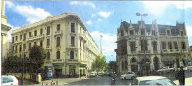
Vista oriente del edificio, desde calle Padre Alonso de Ovalle
