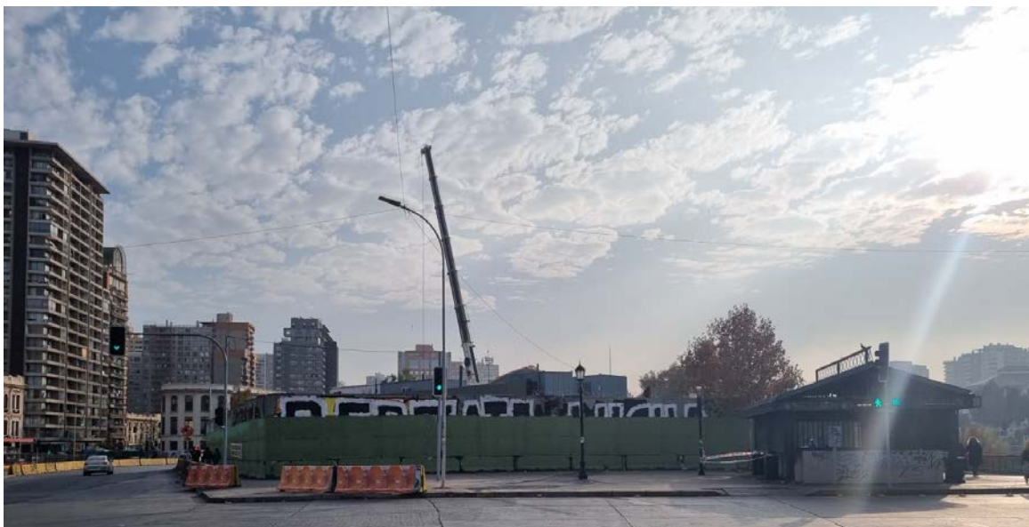
Figura 89. Plaza Venezuela cercada por obras de construcción de la línea 7 del Metro. Fuente: archivo ONG Poloc 2023.
