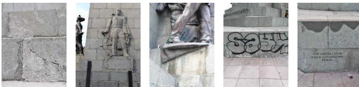
Figura 87. Alteraciones y deterioros presentes en la escultura “Héroes de Iquique”, realizada por el escultor José Caroca Laflor. a) Pérdida de materia, deplacamiento en el pedestal; b) Pérdida de elementos; c) Corrosión y abrasión de la superficie del bronce y manchas y escorrentías en la piedra; d) Grafitis y rayados; e) Manchas de grasa sobre la piedra. Fuente: archivo ONG Poloc 2022.
