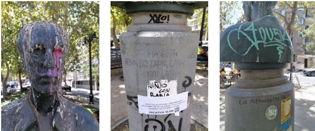
Figura 77. Alteraciones y deterioros presentes en la escultura del pianista Arnaldo Tapia Caballero, realizada por el escultor Galvarino Ponce. a) Suciedad superficial y adherida junto a depósitos de excrementos de aves y pintura; b) Rayados y elementos adheridos sobre superficie de columna. c) Grafiti, rayados y elementos adheridos (stickers) en la zona posterior del busto. Fuente: archivo ONG Poloc 2022.
