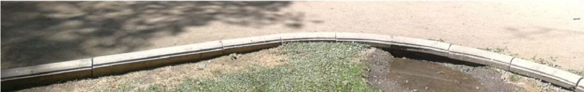
Figura 218. Fotografía del bordillo tipo Parque Forestal instalado en el Parque, delimitando un sendero sinuoso. Fuente: ONG Poloc.
