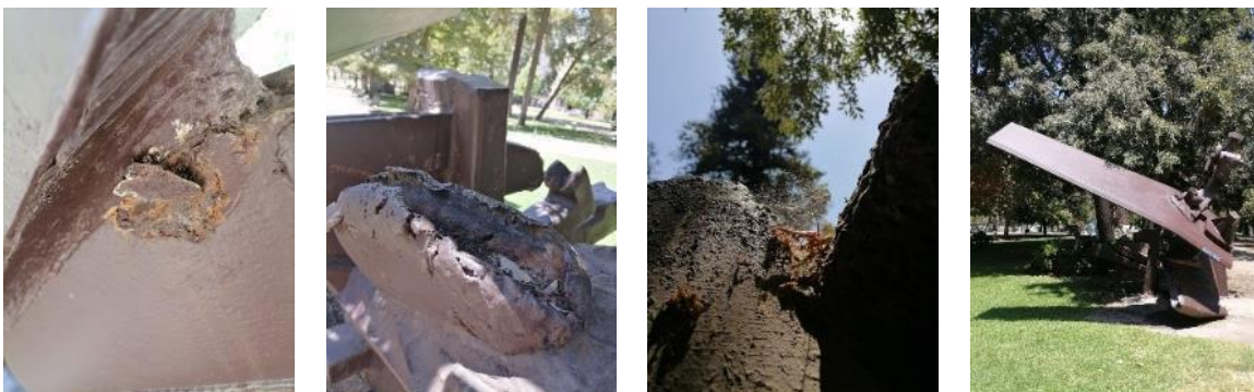
Figura 74. Alteraciones y deterioros presentes en escultura “Oda al Fierro”, realizada por el escultor Francisco Gacitúa. a) Corrosión activa bajo la capa de pintura café; b) Pérdida de materia por corrosión; c) Colonización biológica; d) Grafitis y capa de pintura de color café en toda la superficie. Fuente: archivo ONG Poloc 2022.
