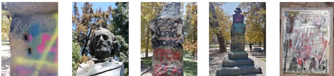
Figura 78. Alteraciones y deterioros presentes en el busto del General Bartolomé Mitre, realizada por el escultor Juan Anton Sepúlveda. a) Perforaciones en la piedra del pedestal; b) Depósitos de excrementos de aves, suciedad superficial y adherida; c) y d) Graffitis, rayados; e) Elementos adheridos, grafitis sobre placa de identificación municipal. Fuente: archivo ONG Poloc 2022.
