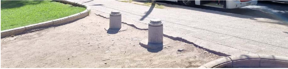
Figura 196. Fotografía de un mal encuentro entre un sendero con pavimento de maicillo en el interior del Parque Forestal y una acera de una vía transversal al Parque. Fuente: archivo ONG Poloc 2023.
