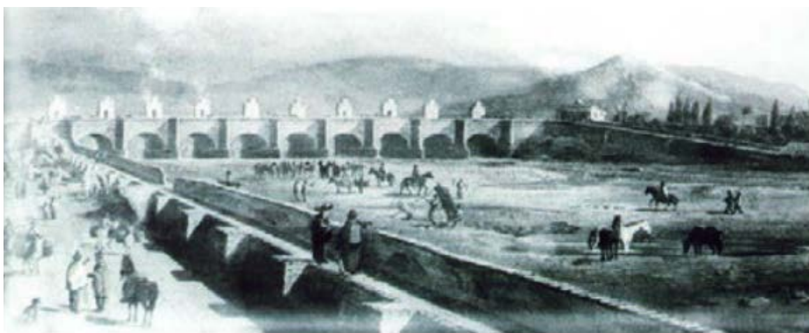
Figura 5. “El Tajamar del río Mapocho y el Puente de Cal y Canto” –según pintura del viajero inglés Carlos Wood (c. 1825)– mostrando el concurrido sector de Mapocho y Puente, con La Chimba a la derecha. Reproducida en Liisa Voionmaa, Escultura pública. Santiago 1792-2004, p. 32. Fuente: obtenida de Castillo (2013).
