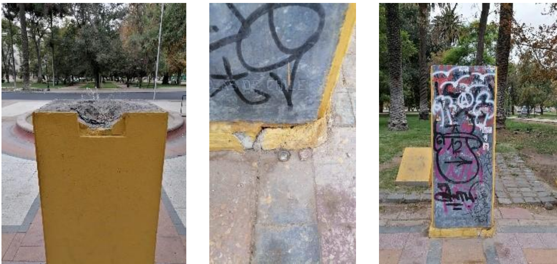
Figura 84. Alteraciones y deterioros presentes en pedestal de la escultura a Cristóbal Colón. a) Pérdida de materia en zona superior del pedestal; b) Roturas en la parte baja del pedestal; c) Grafitis y rayados sobre placa. Fuente: archivo ONG Poloc 2022.
