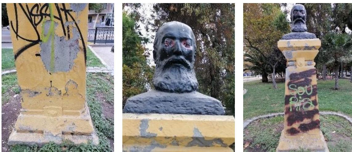
Figura 85. Alteraciones y deterioros presentes en la escultura “Manuel Magallanes Moure”, realizada la escultora Laura Rodig. a) Pérdida de materia, levantamiento de la capa de pintura; b) suciedad superficial y adherida, depósito de excremento de aves y pintura sobre los ojos; c) Grafitis. Fuente: archivo ONG Poloc 2022.
