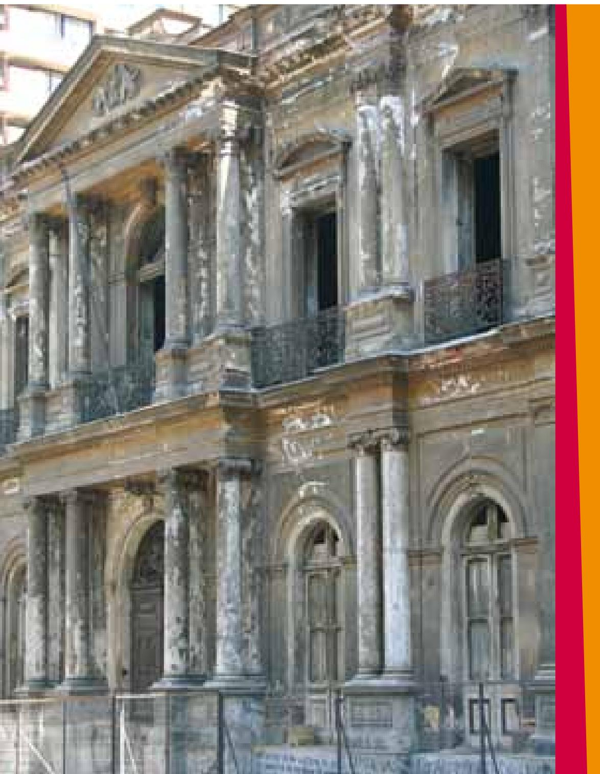
El Palacio Pereira, actualmente abandonado, tiene entre sus elementos constructivos fundamentales, una estructura de albañilería con mortero de cal, con muros perimetrales de 0,80 m ; armadura de techumbre de madera de roble parcialmente conservada; cubierta de fierro galvanizado; mármol en el revestimiento del zócalo del exterior y en el pavimento en las galerías interiores vidriadas.
