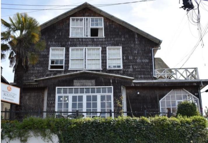
Se consolida desde el S.XVII hasta 1820, bajo el sistema de tabiquería en base a pilares seguidos con piezas horizontales o soleras, unidas por ensambles y tarugos.
