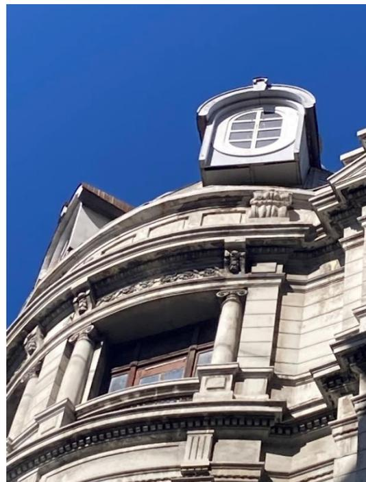
Figura 118. Reconstrucción deficiente de ventana en cúpula del edificio Ex Bolsa de Corredores. Fuente: Elaboración propia.
