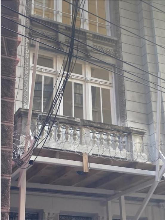
*Figura 68. Edificio Bolsa de Corredores de Valparaíso, presenta corrosión de algunos elementos estructurales metálicos en sus balcones. Fuente: elaboración propia.*
