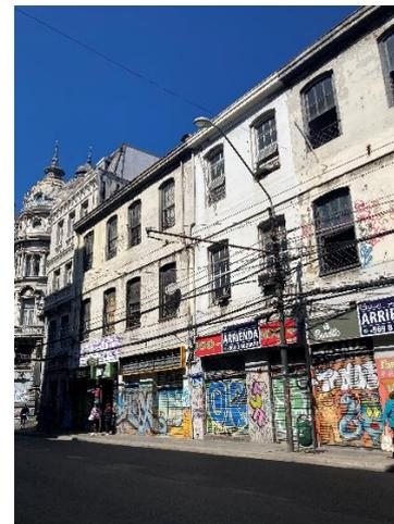
Figura 148. Letreros sobrepuestos que ocultan la parte superior de los vanos y pilastras del primer nivel. Interfiere con la apreciación de la fachada del edificio.
