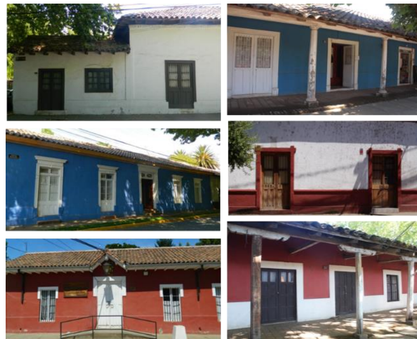
Imágenes 38: Situación actual de pinturas en fachadas del sector A.
