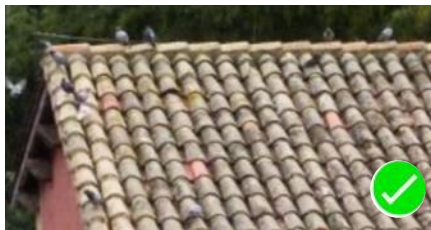
ALTAMENTE RECOMENDABLE: TEJAS DE ARCILLA EN CUBIERTAS VISIBLES DESDE EL ESPACIO PÚBLICO
