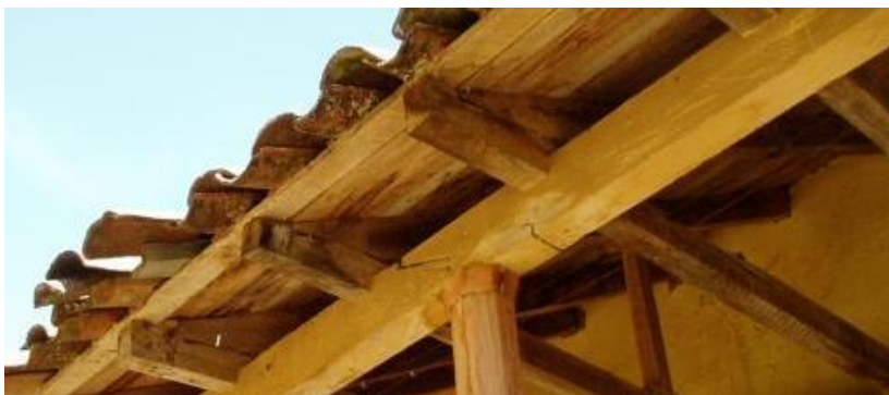
Imagen 35: Ensamblaje y empalme característicos en piezas de vigas y cerchas.
