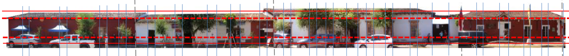
Imagen 19: Composición general de la fachada continua (elementos compositivos, ritmo de vanos y proporción lleno-vacío). Fuente: OTR Maule
