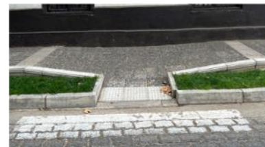
Rebaje de solera para cruce peatonal
