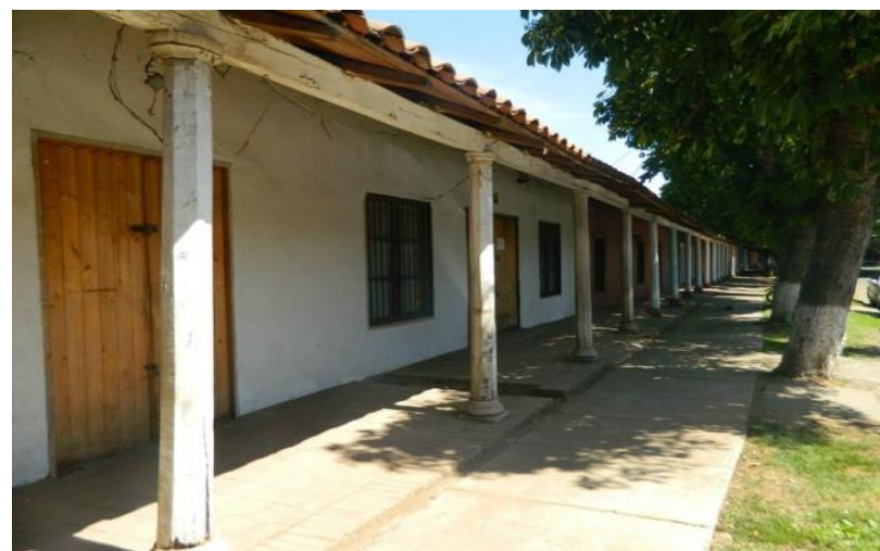
Imagen 14: Corredor continuo en Av. Centenario. Fuente: OTR Maule.
