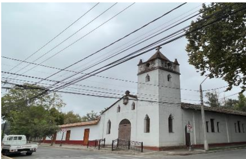
Imagen 47: Situación actual de cableado en sectores con alta concentración de inmuebles de alto valor.
