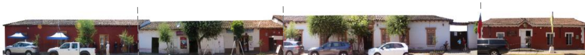
Imagen 18: Levantamiento fachadas Av. Centenario (tramo inicial de inmuebles en fachada continua sin corredor). Fuente: OTR Maule
