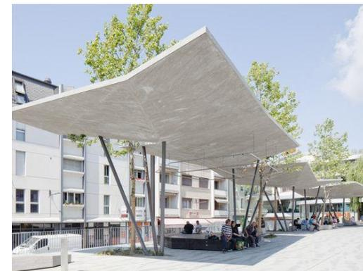
**Nota:** Ejemplo de sobre diseño, baja protección de viento y lluvia.
