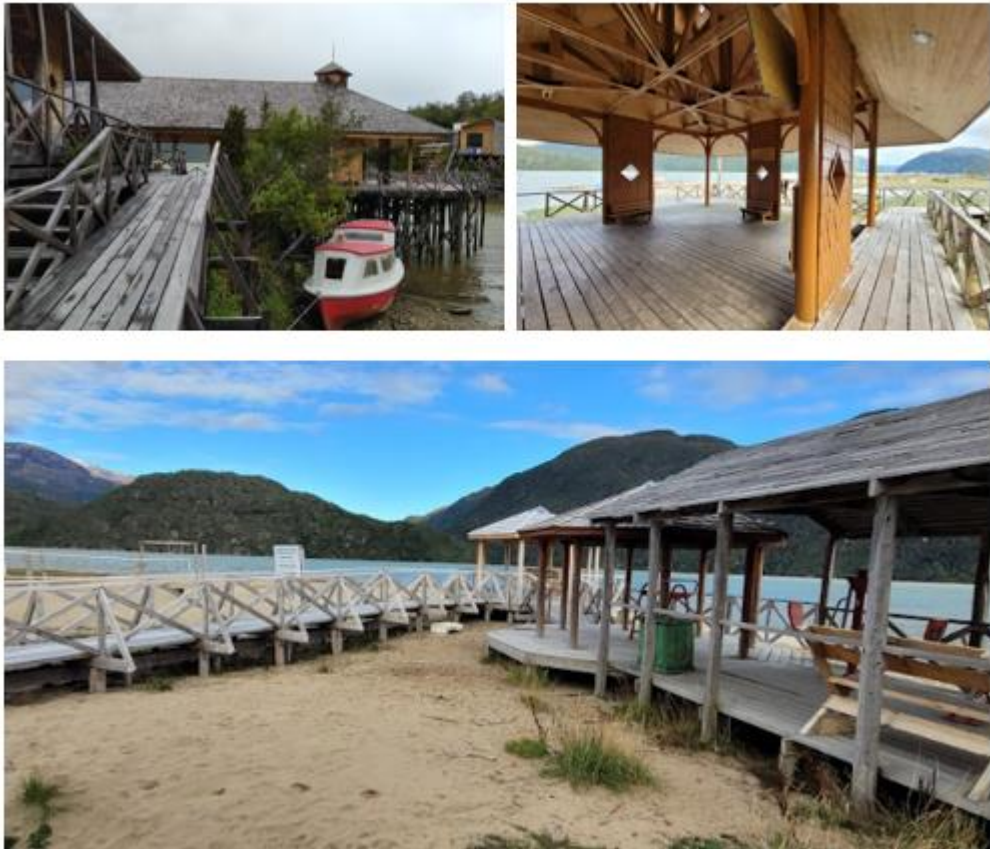
Ilustración 86: Fotografías representativas de espacios de permanencia. Registro realizado por la Oficina Técnica Regional de Aysén del CMN.
