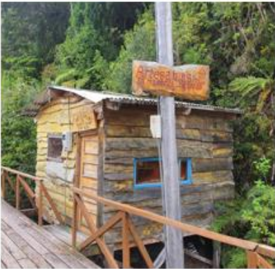
Fijación en poste de tendido eléctrico.
