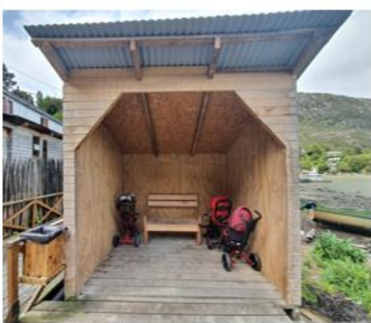
Revestimiento de planchas de zinc alum sin pintar
