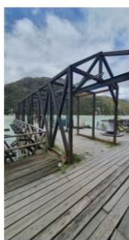
Estructura de acero en negro.
