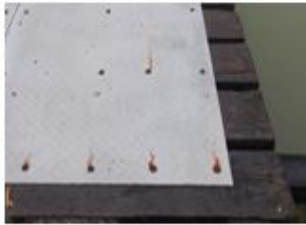
Escaleras de acero galvanizado en verde
