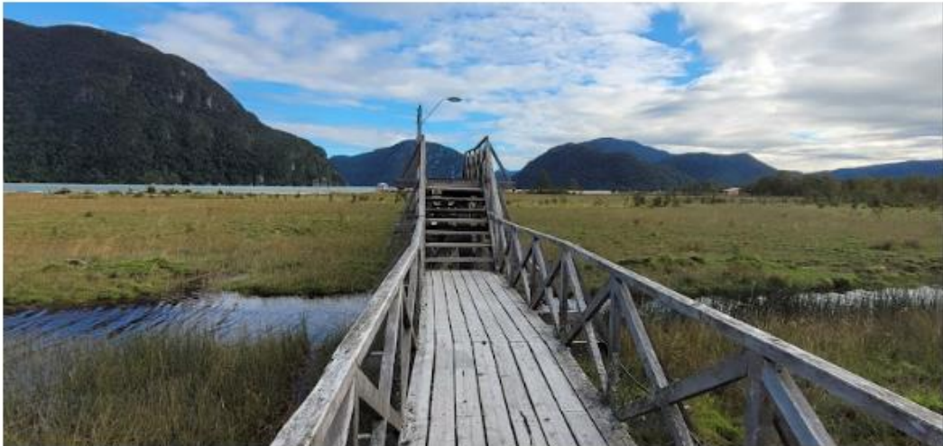
Pasarela que cruza humedal bajo, en el sector Junquillo
