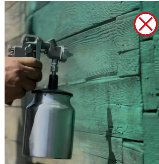
Ejemplo de procedimientos no recomendados: lijado con esmeril y disco altamente abrasivo; aplicación de pintura directamente sobre maderas.
