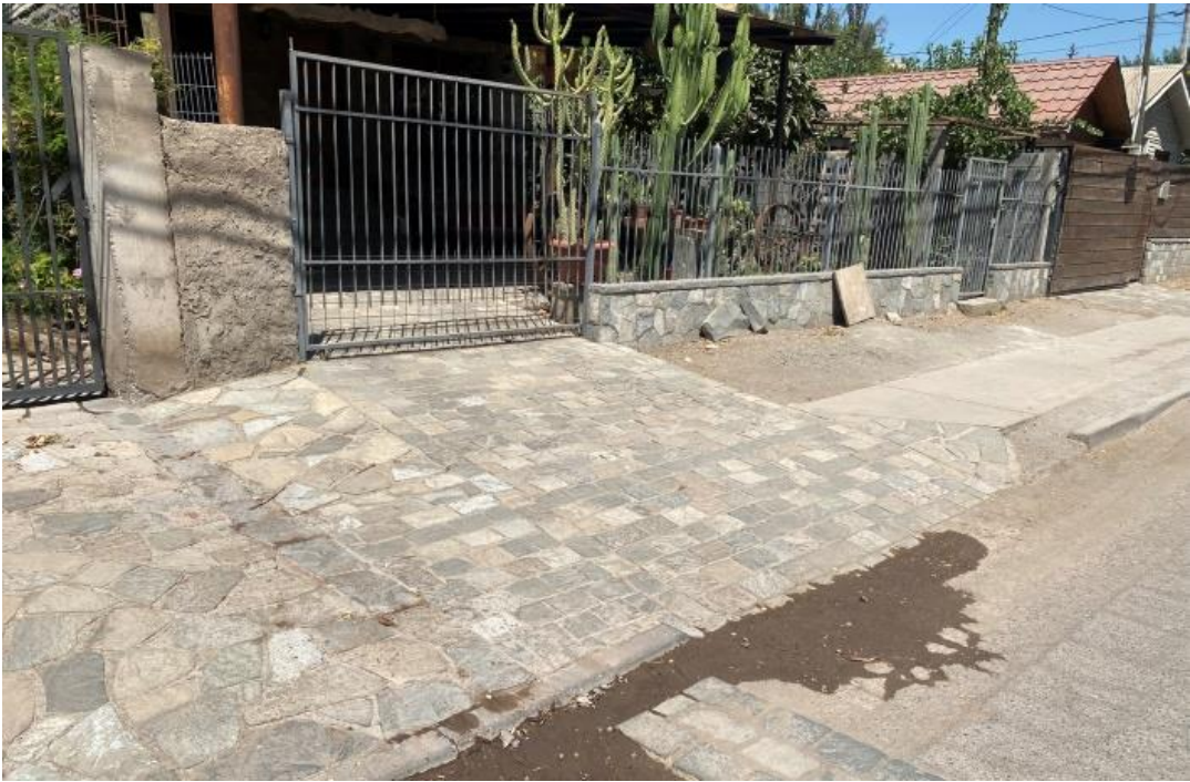
Pie de figura. Fotografías de la ZT que muestran escalinatas, rampas y accesos vehiculares. Fuente: ST CMN, 2024.
