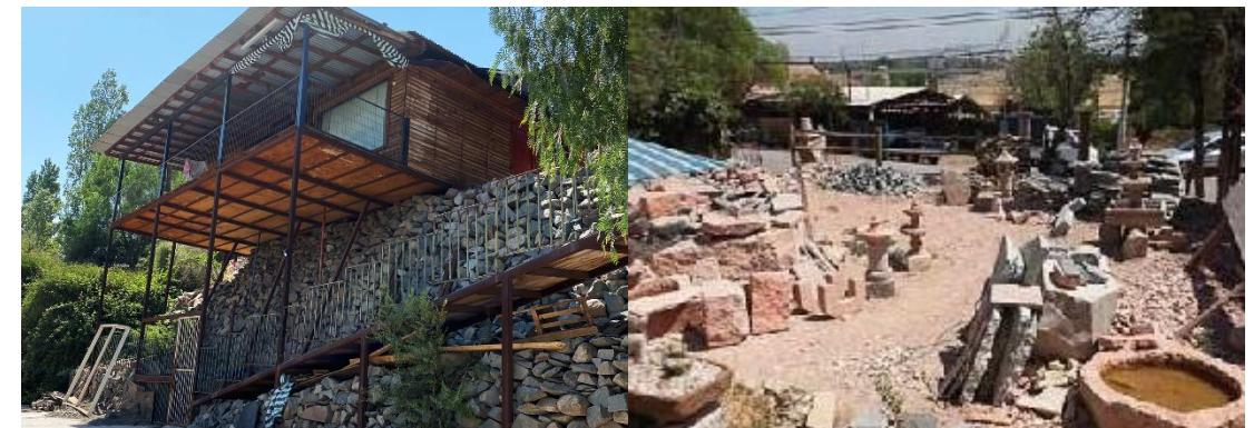
Pie de figura. Inmueble adecuado a la pendiente y taller de trabajo de la piedra. Fuente ST CMN, enero 2022.
