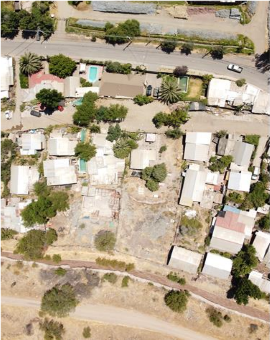
Pie de figura. Vista aérea techumbres de la ZT. Fuente: ST CMN, 2024.
