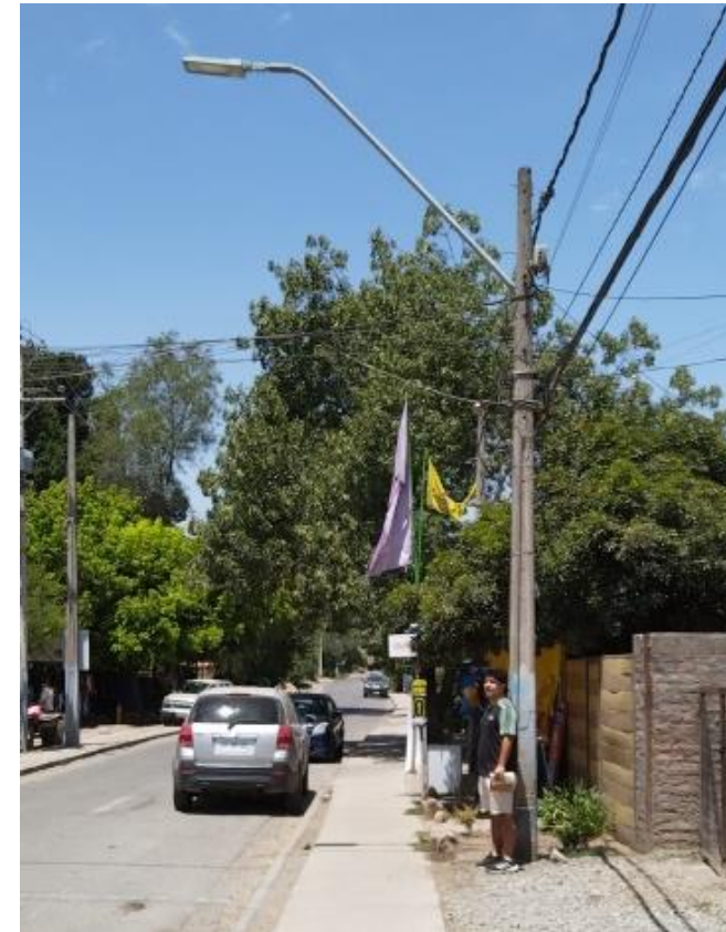
Luminaria vial existente
