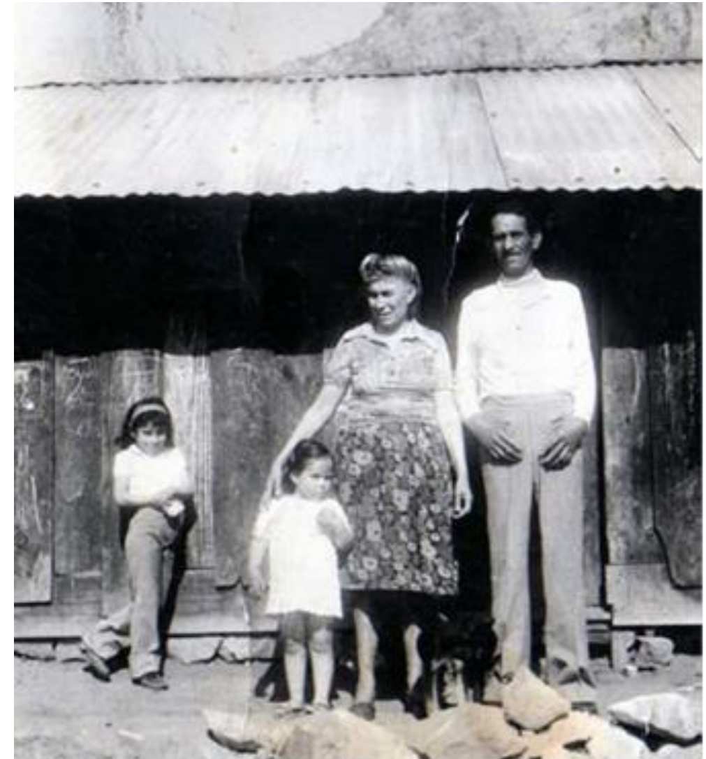
Pie de figura. Construcción de tablones provenientes de desarmes de campamentos, cimientos de piedra, fonolas de metálicas. Archivo R. Abarca. 1970. Fotografía de la familia Calderón / Cruz. (Garcés, pág. 139)
