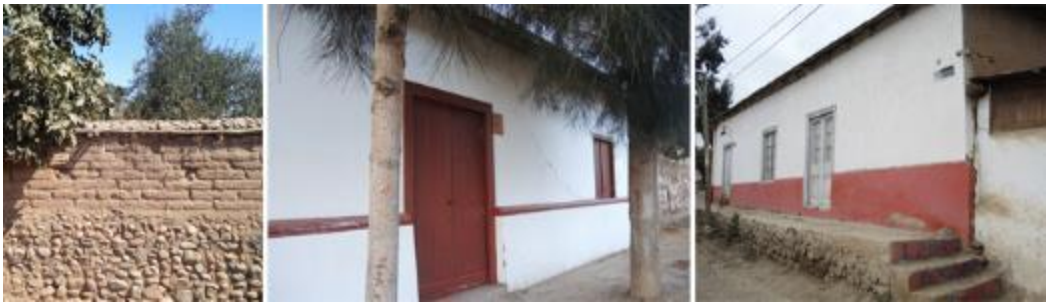
Figura 69. Tipos de zócalos presentes en el Poblado de Barraza.
