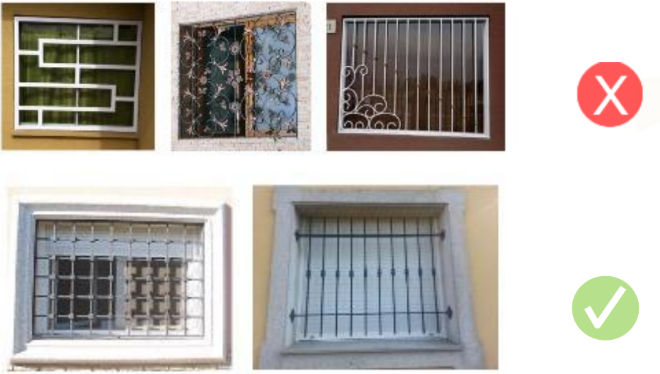
Figura 78. Para protecciones en ventanas se espera el uso de barrotes de fierro lisos, dispuestos de forma regular a modo de los ya existentes.
