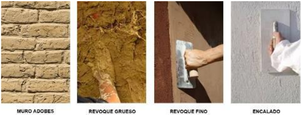
Figura 74. Etapas en la instalación de revestimientos de barro en muros.
