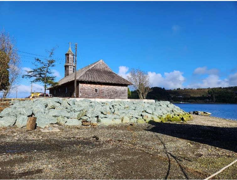
Imagen 49. Proyecto de enrocado en borde costero. Fuente: OTP Chiloé, 2024.
