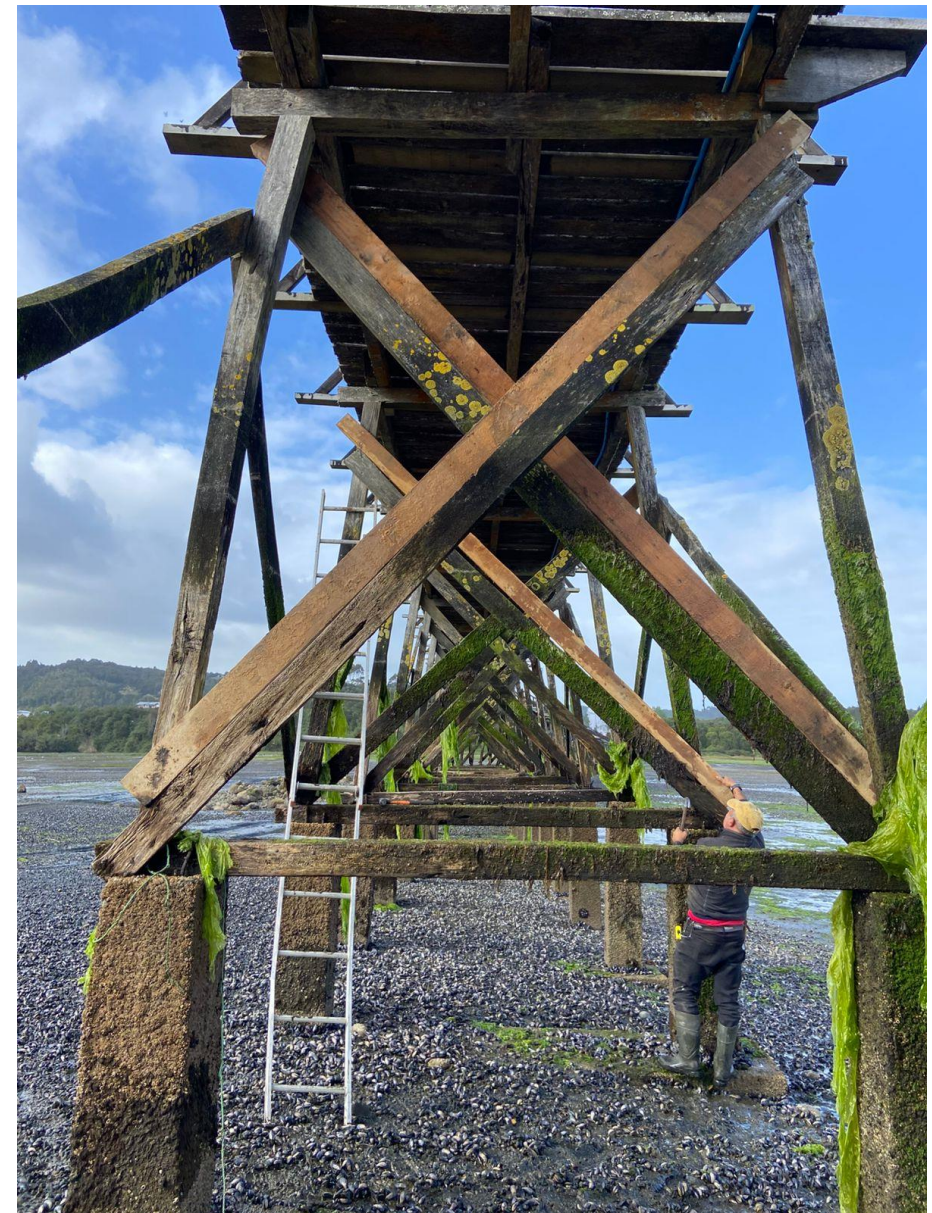
Imagen 62. Obras de reemplazo de las diagonales de la pasarela de isla Aucar. Fuente: Registro personal de Patricio Aguilar, noviembre 2025.
