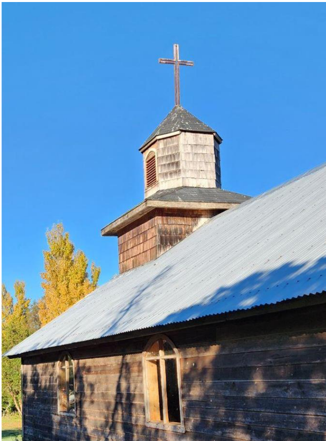
Imagen 114. Forma y materiales de la cubierta para los edificios de la ZT en isla Aucar. Fuente: ST CMN, 2025.
