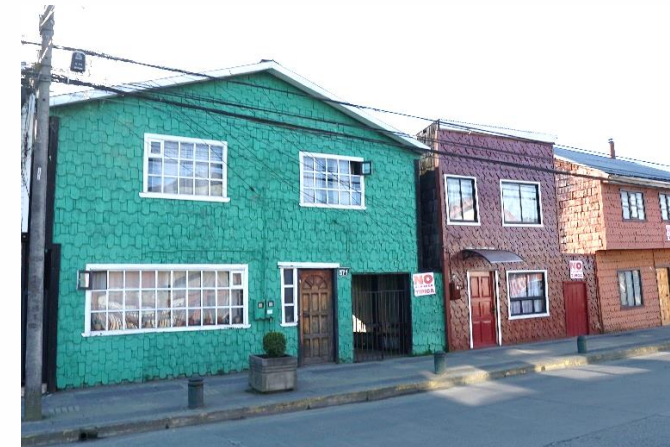
Ejemplos de pintura en inmuebles de la Zona Típica. Fuente: Elaboración propia.
