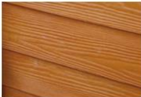
ACANALADO DE SIDING
