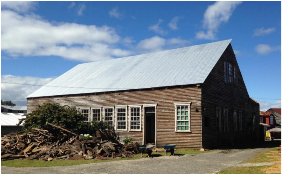
Ejemplo de mantención y reparación de techumbre. Fuente: Elaboración Propia.
