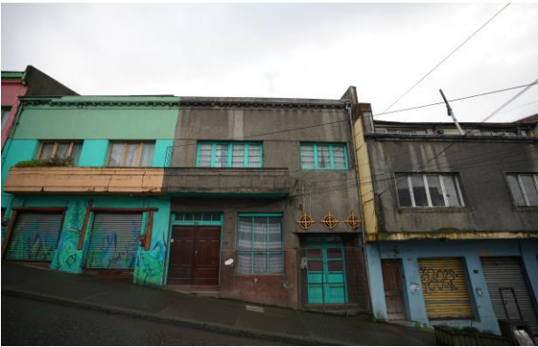
Fotografía calle Blanco Encalada. Inmuebles representativos de las edificaciones con agrupamiento de fachada continua. Fuente: Elaboración propia.
