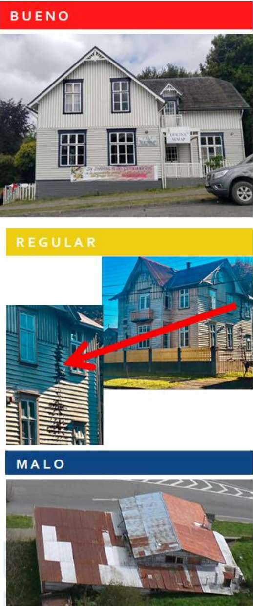
Figura 25. Imágenes de la ZT y la definición de criterios de conservación para el fichaje en terreno. Fuente: ST CMN, 2025
