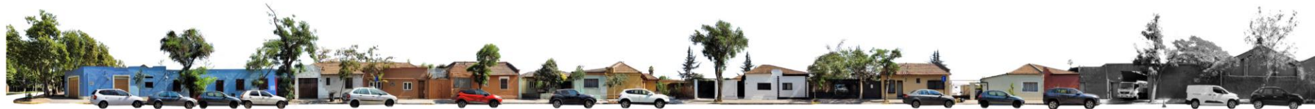
CALLE EMILIO DELPORTE. FACHADA SUR
