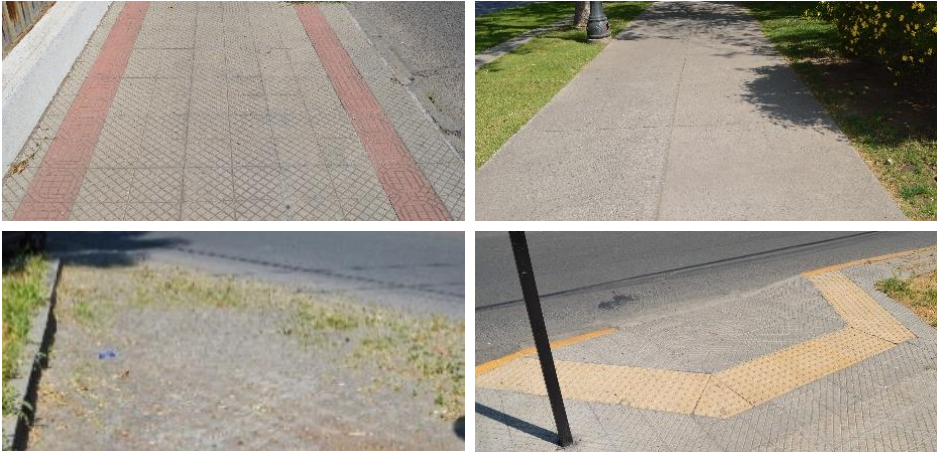
Fig. 91 - 94: Pavimento presente en la ZT. Fuente: Consultora Principios Patrimonio Chile.
