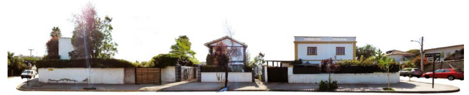
CALLE JOSÉ TOMÁS RIDER. FACHADA PONIENTE. TRAMO 2
