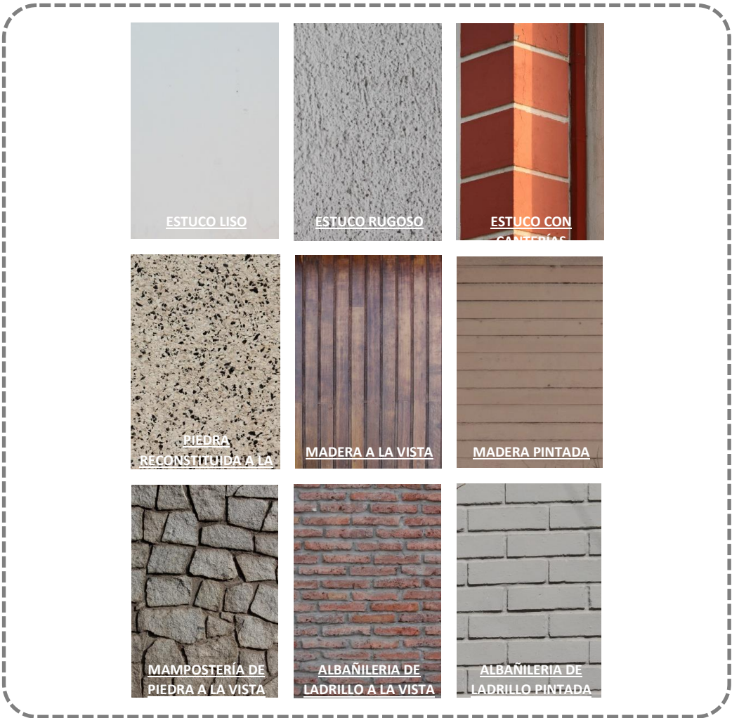
Fig. 311: Ejemplos de revestimientos de muro existentes. Fuente: Consultora Mireya Danilo (Equipo: Mireya Danilo, Cristina Briño y Fernando Navarro).
