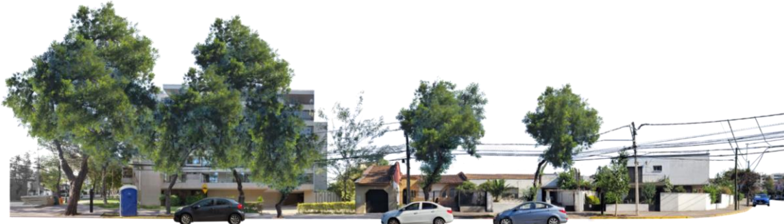
CALLE JOSÉ LUIS AGUILAR. FACHADA SUR. TRAMO 1
