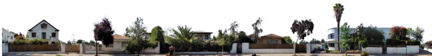
CALLE DALMACIA. FACHADA NORTE
