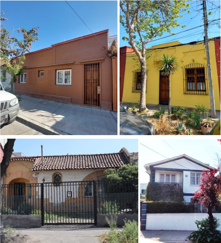
Fig. 268 - 271: Ejemplos de inmuebles sin alteración. Fuente: Consultora Principios Patrimonio Chile.
