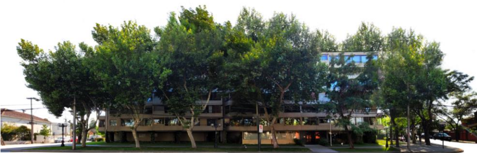
CALLE MIGUEL CLARO. FACHADA PONIENTE. TRAMO 4
