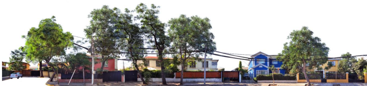
CALLE JUAN AGUSTÍN BARRIGA. FACHADA NORTE
