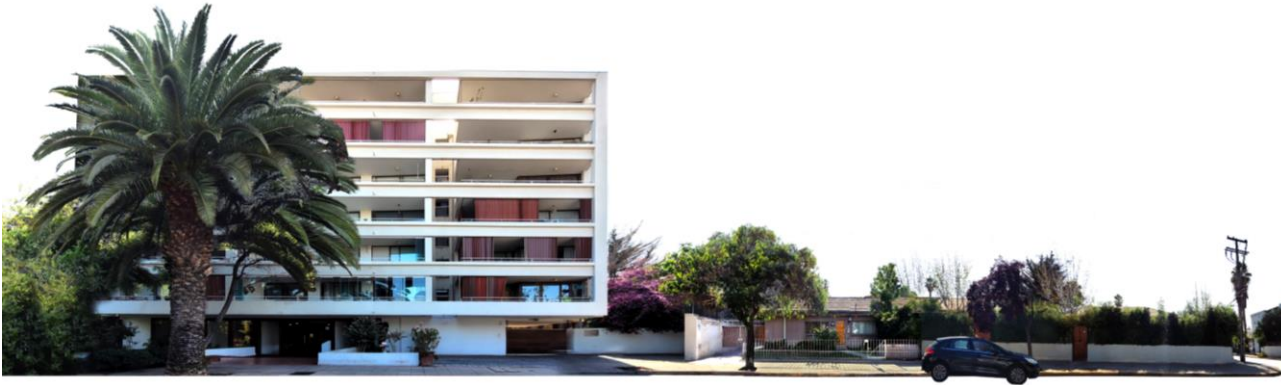
CALLE JOSÉ TOMÁS RIDER. FACHADA PONIENTE. TRAMO 1
