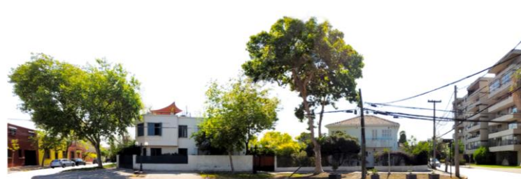
CALLE MIGUEL CLARO. FACHADA PONIENTE. TRAMO 3
