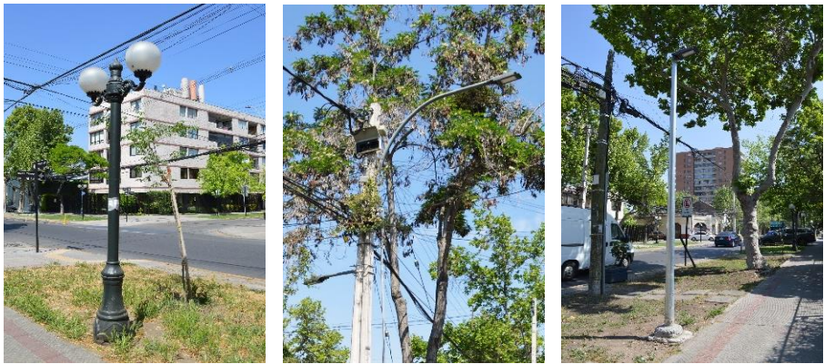
Fig. 104 - 106: Luminaria presente en la ZT. Fuente: Consultora Principios Patrimonio Chile.
