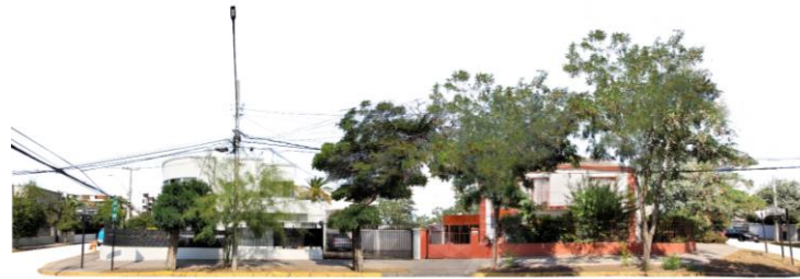
CALLE JOSÉ TOMÁS RIDER. FACHADA PONIENTE. TRAMO 1
