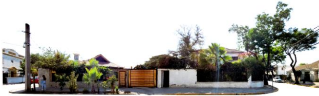
CALLE JOSÉ TOMÁS RIDER. FACHADA PONIENTE. TRAMO 3
