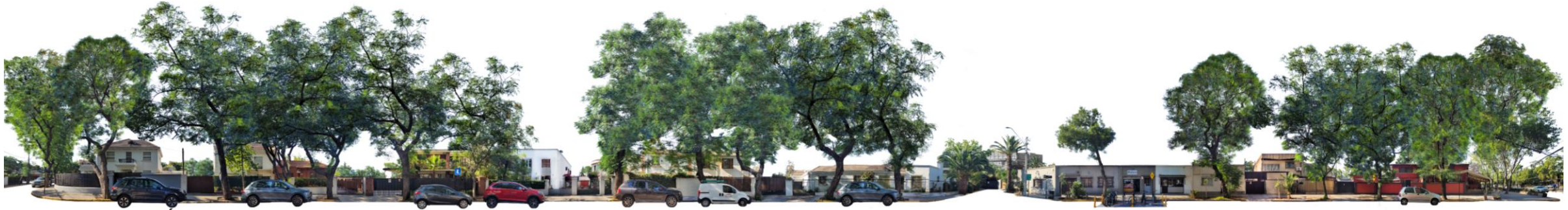
CALLE JOSÉ LUIS AGUILAR. FACHADA NORTE. TRAMO 1 y 2
