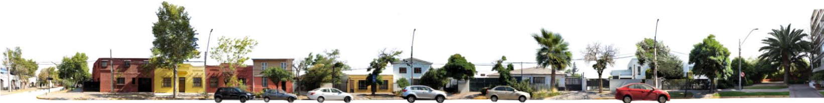
CALLE ÁLVAREZ CONDARCO. FACHADA SUR
