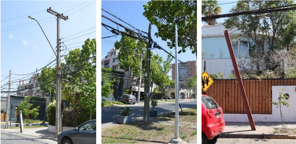
Fig. 117 - 119: Postes presentes en la ZT. Fuente: Consultora Principios Patrimonio Chile.
