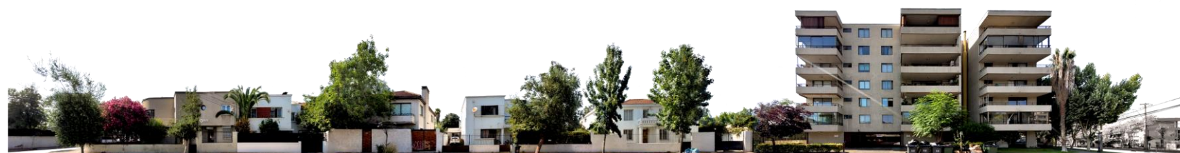
CALLE DALMACIA. FACHADA NORTE
