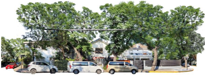
CALLE JOSÉ LUIS CEA. FACHADA ORIENTE
