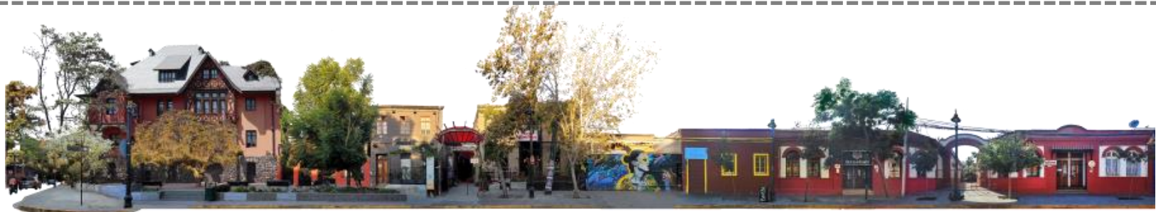
Fig. 182: Se deberá considerar que la vegetación existente complementa la arquitectura de la ZT, en el sentido que permite apreciar su perfil urbano. Dicha condición de visibilidad de la arquitectura deberá perdurar en el tiempo. Fuente: Consultora Mireya Danilo (Equipo: Mireya Danilo, Cristina Briño y Fernando Navarro).
