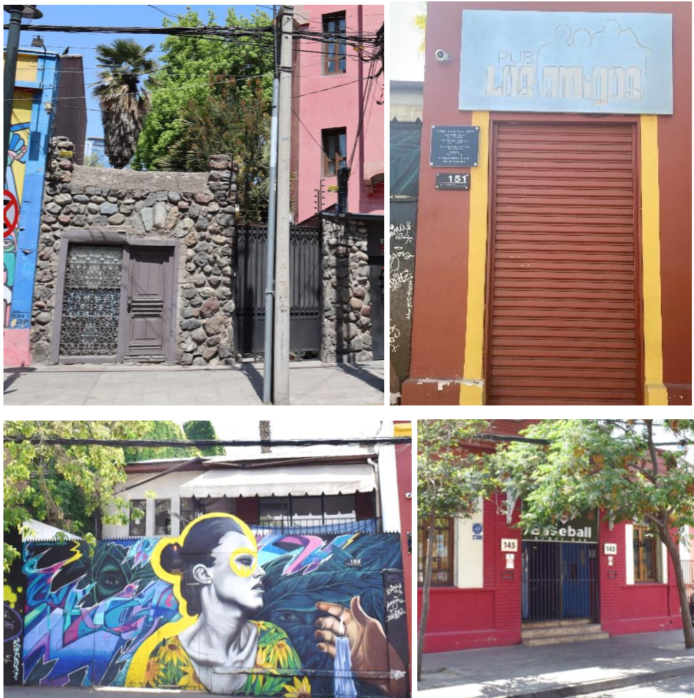
Fig. 120 - 123: Inmuebles que se identifican con alteración que afecta, entre ellas modificaciones de cierre e instalación de carteles o letreros publicitarios. Fuente: Consultora Principios Patrimonio Chile.
