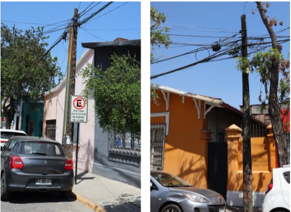
Fig. 75 y 76: Postes presentes en la ZT. Fuente: Consultora Principios Patrimonio Chile.
