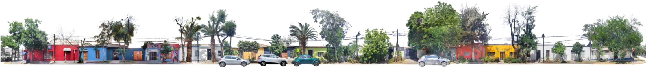
CALLE ARZOBISPO CASANOVA FACHADA ORIENTE.
