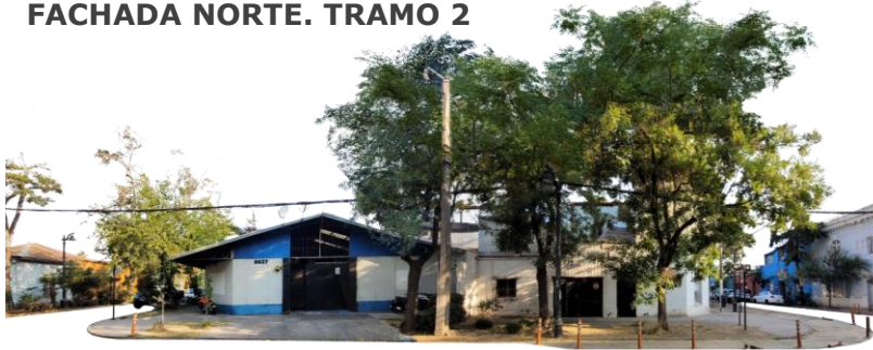
CALLE ANTONIA LÓPEZ DE BELLO. FACHADA NORTE. TRAMO 2
