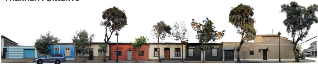
CALLE ISABEL RIQUELME. FACHADA PONIENTE
