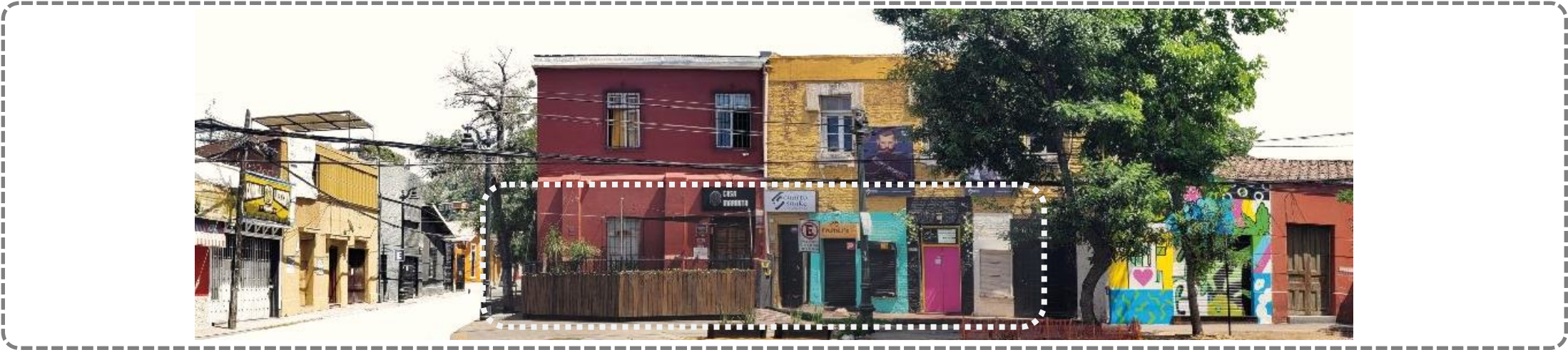
Fig. 258: Ejemplo de alteraciones consideraras inadecuadas en vanos. Fuente: Consultora Mireya Danilo (Equipo: Mireya Danilo, Cristina Briño y Fernando Navarro).
