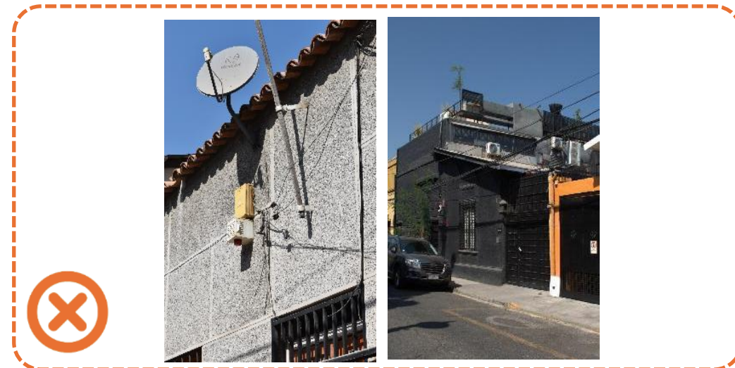
Fig. 262: Elementos discordantes no permitidos, existentes en la ZT. Fuente: Consultora Mireya Danilo (Equipo: Mireya Danilo, Cristina Briño y Fernando Navarro).
