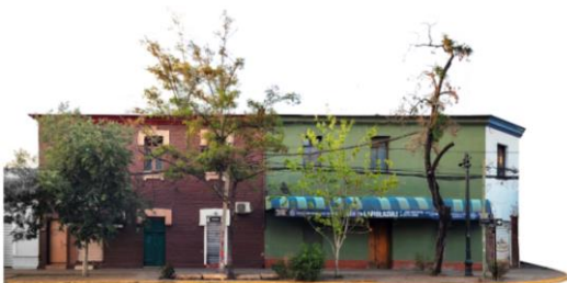
CALLE BELLAVISTA. FACHADA SUR. TRAMO 1
