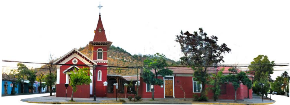
CALLE BELLAVISTA. FACHADA SUR. TRAMO 6
