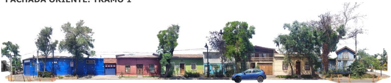
CALLE CAPELLÁN ABARZÚA. FACHADA ORIENTE. TRAMO 1
