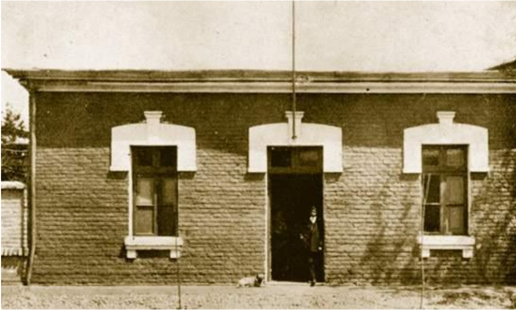
Fig. 32: Vivienda de fachada continua en Población León XIII hacia 1910. Fuente: Memoria Chilena.
