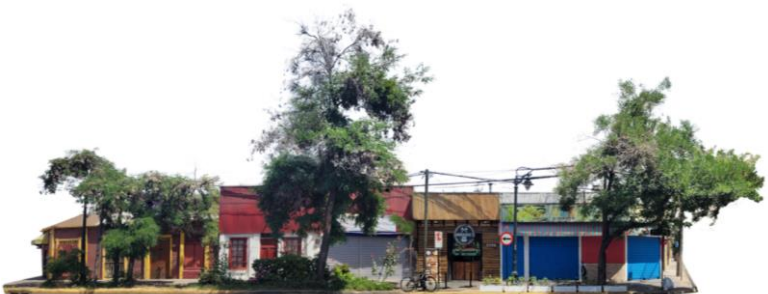
CALLE BELLAVISTA. FACHADA SUR. TRAMO 2
