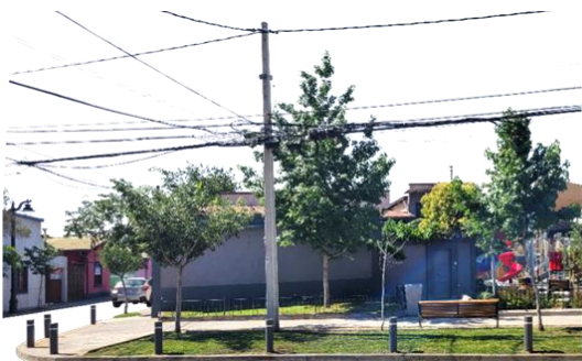
CALLE NUEVA DARDIGNAC. FACHADA NORTE. TRAMO 3
