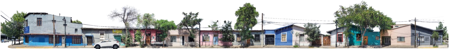
CALLE SALVADOR DONOSO. FACHADA ORIENTE
