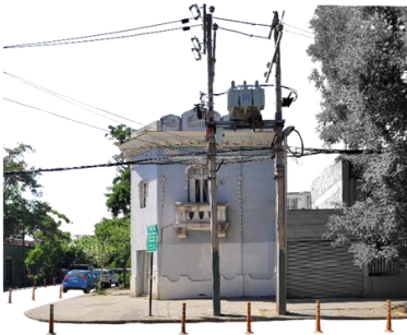
CALLE ANTONIA LÓPEZ DE BELLO. FACHADA NORTE. TRAMO 3
