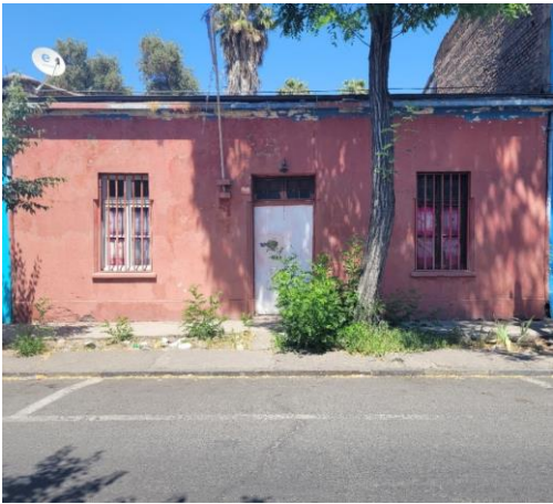
Fig. 216 - 217: Ejemplos de inmuebles sin alteración. Fuente: Consultora Principios Patrimonio Chile.
