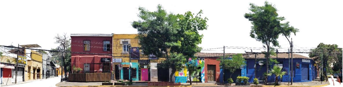
CALLE BELLAVISTA. FACHADA SUR. TRAMO 4
