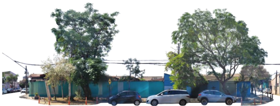
CALLE NUEVA DARDIGNAC. FACHADA NORTE. TRAMO 2
