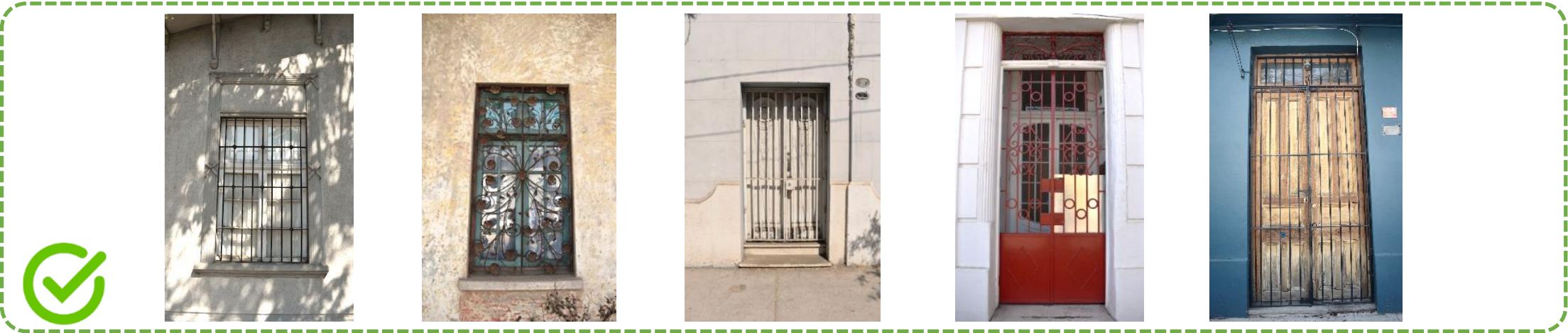
Fig. 284: Ejemplo de protecciones metálicas en puertas y ventanas existentes y permitidas. Fuente: Consultora Mireya Danilo (Equipo: Mireya Danilo, Cristina Briño y Fernando Navarro).
