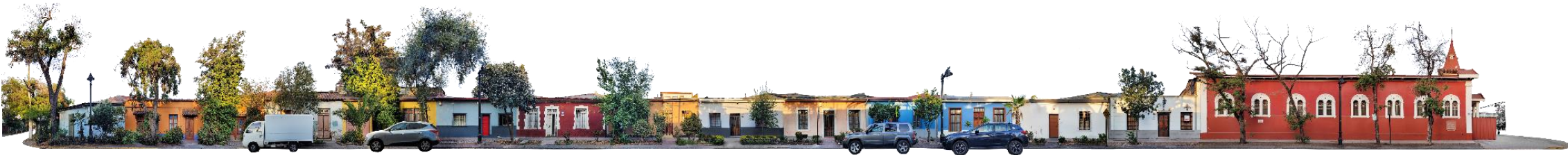
CALLE ARZOBISPO CASANOVA. FACHADA PONIENTE.
