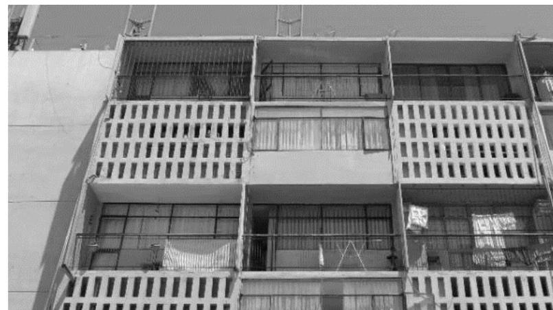
**Figura 16:** Imagen de la fachada modular (ventana, balcón, quebrasol), Fuente: Elaboración propia.
