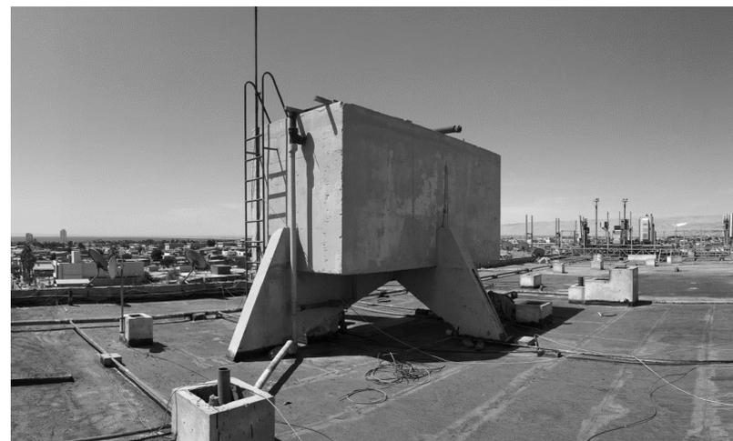
**Figura 17:** Imagen de la terraza del edificio, en primer plano una de las dos copas de agua, Fuente: Elaboración propia.
