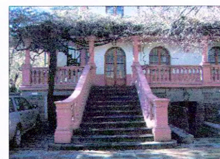
Escalera Poniente Acceso a 2 piso
