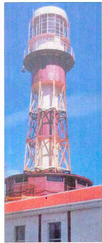
Estructura metálica de la torre.
