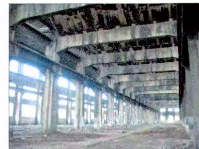
Vista interior del Taller de Armadura (1)
