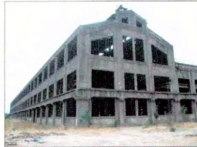
Taller de Armadura (1)
