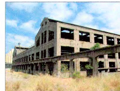
Taller de Armadura (1)
