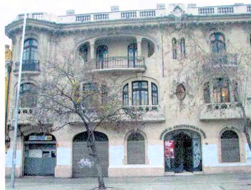
Actual fachada principal
