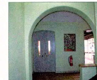
Vista hall acceso a Casa de Administración
