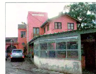
Vista Casa de Administración desde calle Canadá
