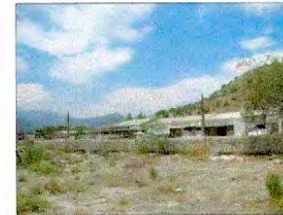
Vista de bodega
