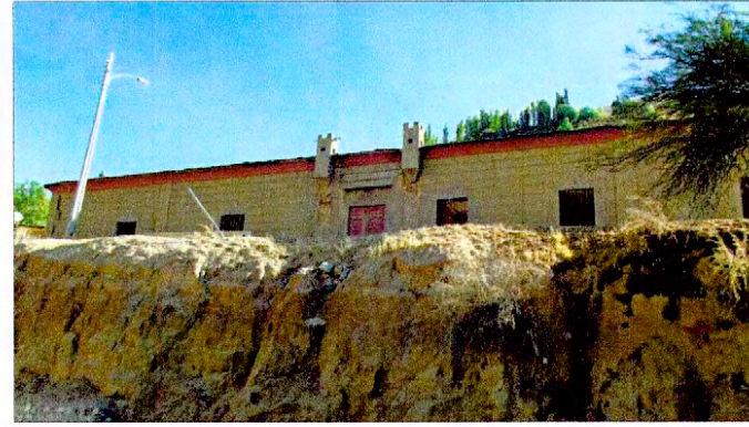
Vista a escuela desde actual camino principal
