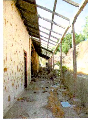
Vista corredor externo posterior
