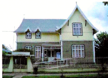
Vista fachada principal por calle Manuel Rodríguez
