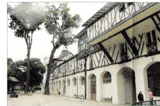
Vista fachada norte sector apuestas y paddock.
