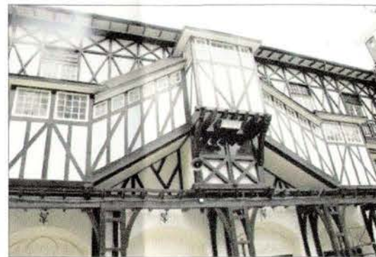
Detalle de carpintería en madera, fachada norte.
