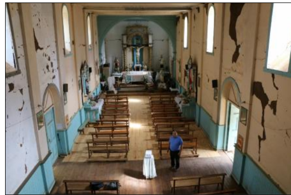
Vista Interior de Iglesia San Luis Gonzaga de Vilches
