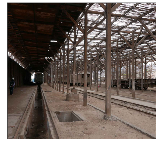
Vista interior cocheras y corredores
