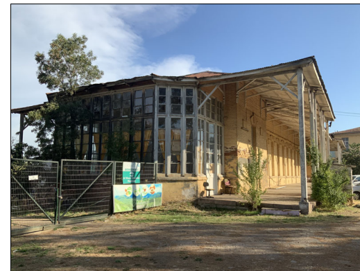
Vista a pabellón nororiente.
