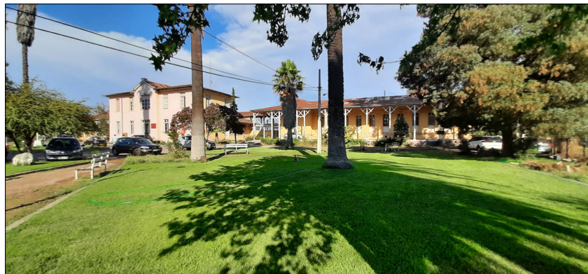
Vista fachada principal desde antejardín.
