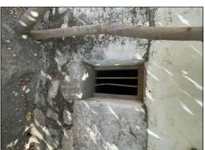
Vista exterior ventana subterránea.
