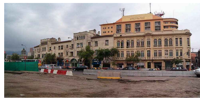
Vista Panorámica Edificio Aillavilú
