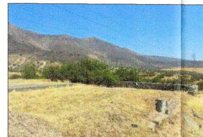
Fundaciones casa de techo rojo
