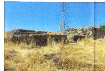
Fundaciones casa de techo rojo
