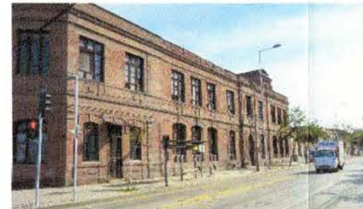
Inmueble esquina calle Carmen con calle Maule
