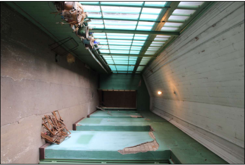
Vista interior del corredor del segundo piso.
