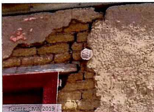
Grietas importantes o pasantes en muros
