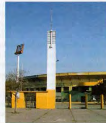
Cierro exterior del Estadio Nacional de Santiago, a Av. Grecia, al fondo el coliseo central
