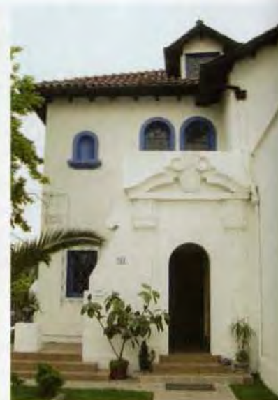
Casa en avenida Salvador 721.
