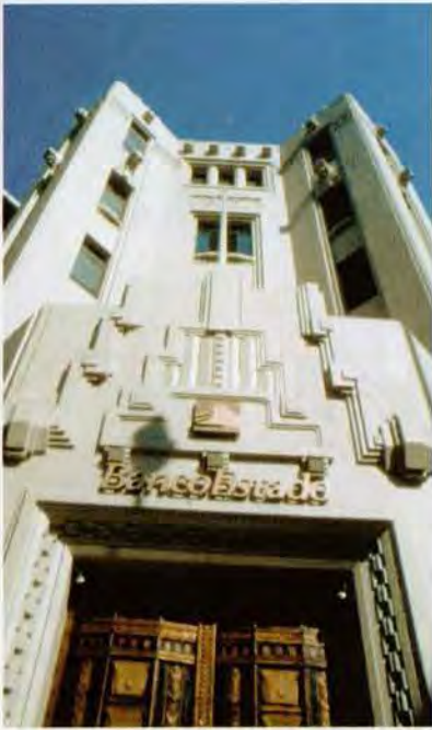
Edificio Ex Caja de Crédito Hipotecario, Santiago. Arqto. Ricardo González C., 1930.
