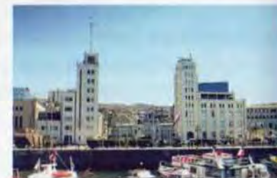
Estación de FF.CC. de Valparaíso. Arqto. L. Humeres, 1936.
