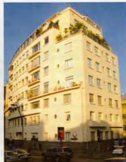
Edificio Santa Lucía, Santiago. Arqto. S. Larraín G.M. y J. Arteaga, 1934.
