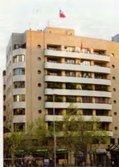
Edificio FFCC, actual Ministerio de Vivienda y Urbanismo, Santiago. Arqto. E. Costabal y A. Garafulic, 1934.
